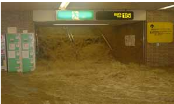
H15.7 地下施設浸水（福岡市）
