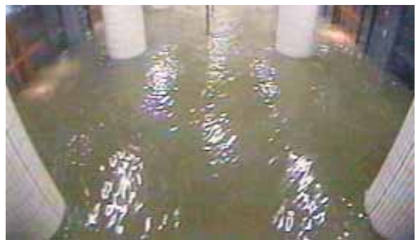
H16.10 地下鉄ホーム浸水（東京 麻布十番駅）
