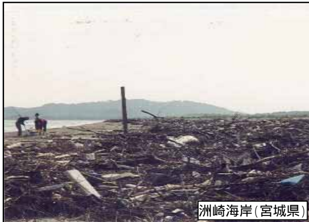
大規模な漂着ゴミを含む流木等の堆積より消波機能が低下した海岸
