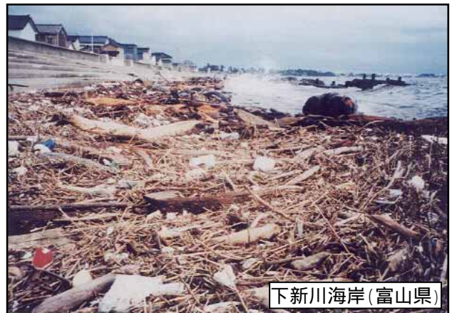
大規模な漂着ゴミを含む流木等の堆積より消波機能が低下した海岸
