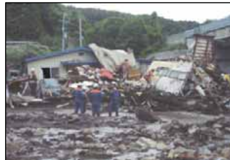
人家等に壊滅的被害 (土石流等被害)
