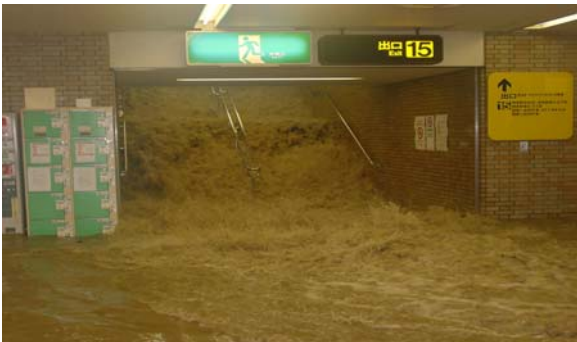
H15.7 地下施設浸水（福岡市）
