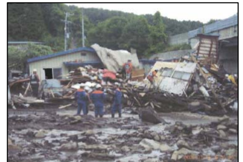
人家等に壊滅的被害 (土石流等被害)
