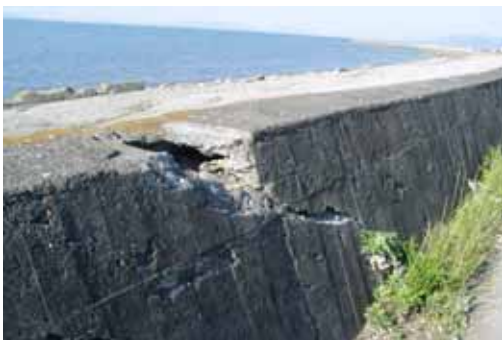
堤防の波返工が損傷
