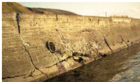
堤防の表法被覆工が損傷
