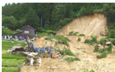
島根県美郷町久保の地すべり状況
