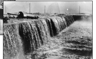
チリ地震(1960年)による津波被害(岩手県 大船渡港)
