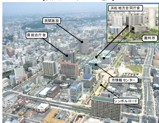
浜松地方合同庁舎
