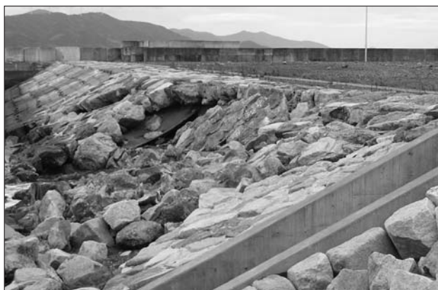
●高知県宿毛湾港護岸の被災(台風4号)
