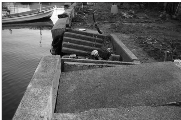
●高知県宿毛湾港護岸の被災(台風4号)
