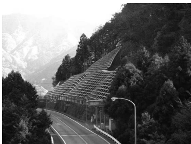
＜斜面崩落防止対策＞
