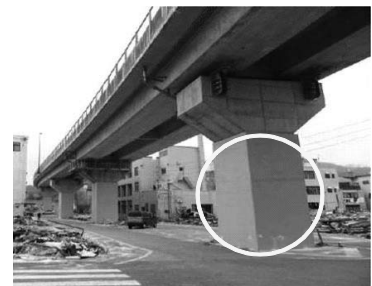
＜橋脚の耐震補強＞
