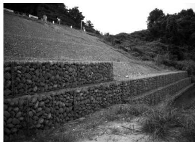
＜盛土のり尻補強＞
