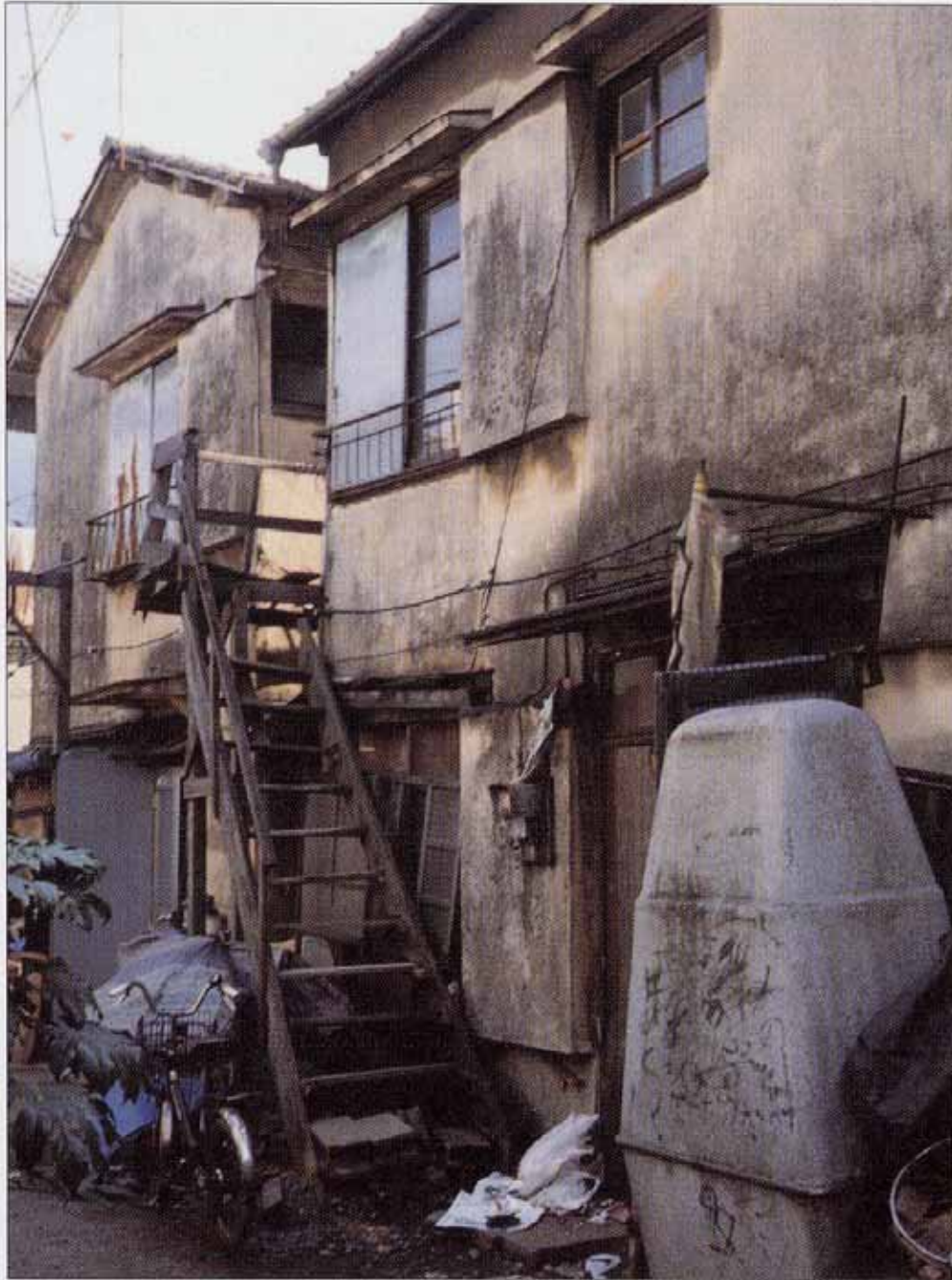
■老朽(不良)住宅の外観
