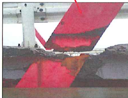
腐食で破断
