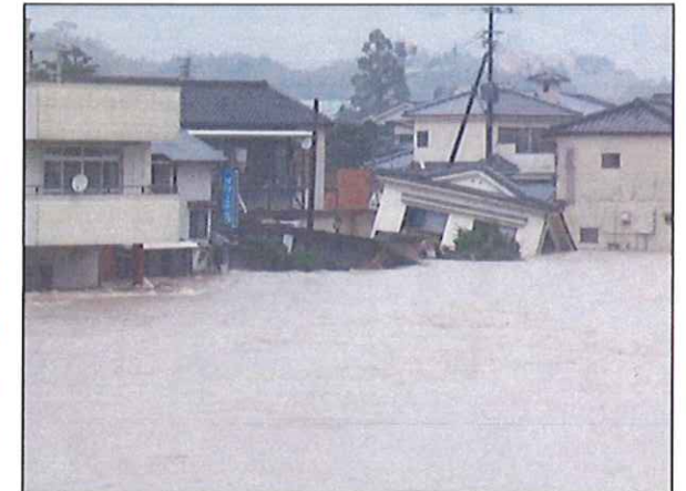
川内川の氾濫による家屋損壊(鹿児島県さつま町)
