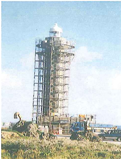
改修工事の状況
