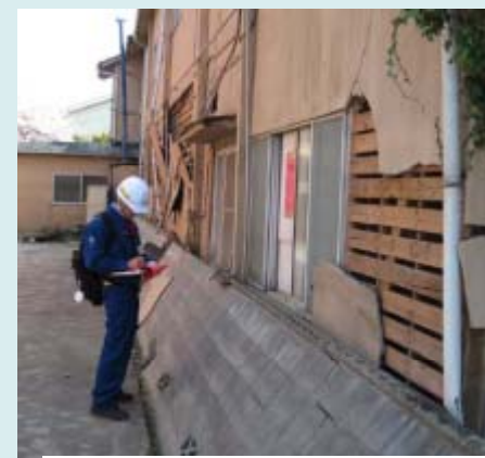
多賀城市内での応急危険度判定
