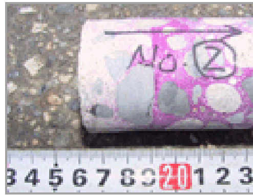
中性化深さの測定例 (フェノールフタレイン法)
