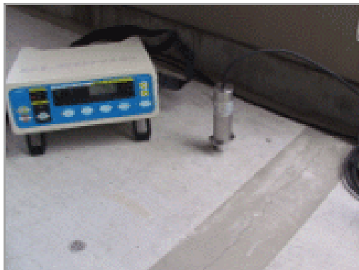
ひび割れ深さの調査例 (超音波法)
