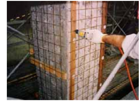
電気化学的防食工法の例 中性化したコンクリートに電気化学的手法で特殊アルカリ溶液を浸透させ再アルカリ化
