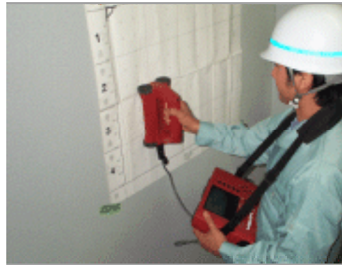
鉄筋探査の例 (電磁誘導法)
