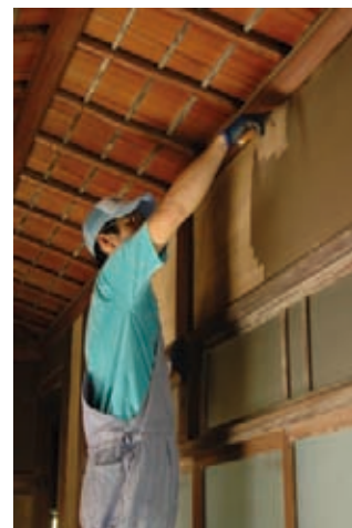
屋根瓦の補修やシロアリに喰われた床下など、どうしてもプロの手を借りなければならない箇所以外は、プロの助言や指導を得ながら自分たちの手で改修した。改修にかけた費用はトータルで100万円に満たない
