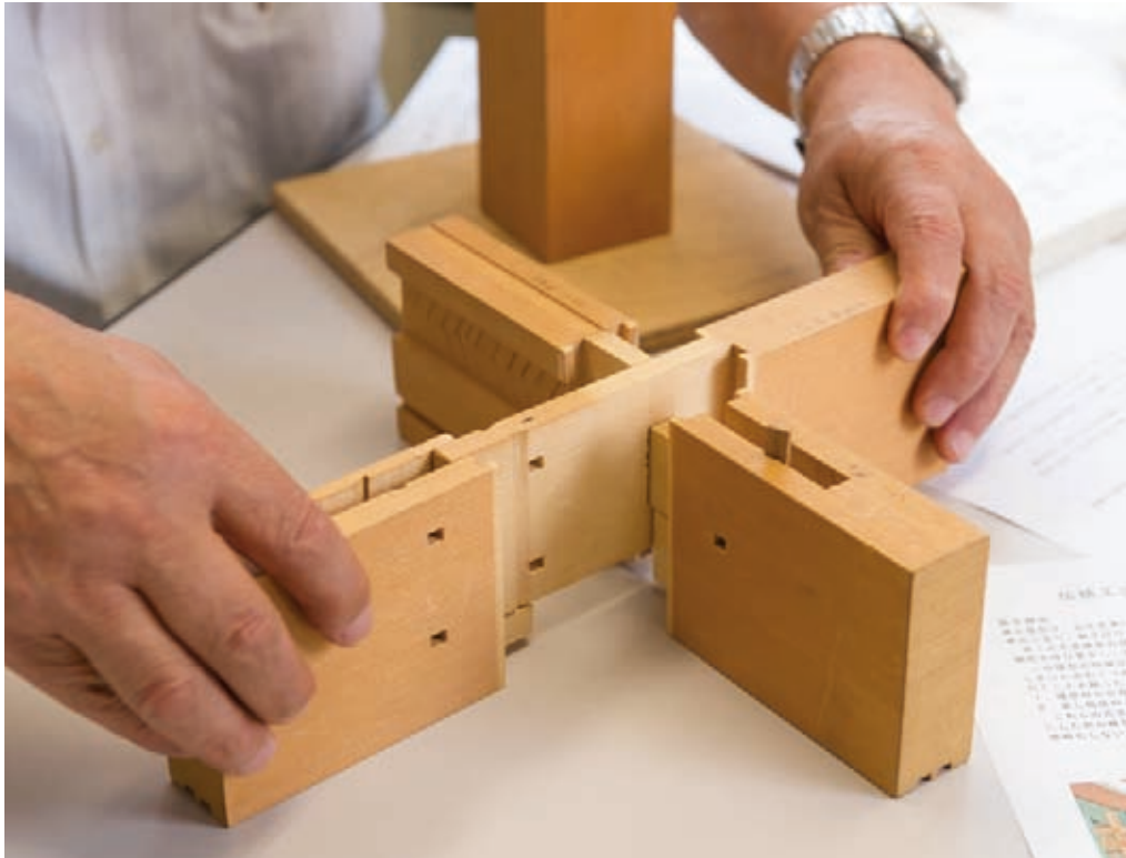
日本の伝統工法では複雑に木を組み合わせて柱、梁などを組み立てていく。地域によって構法には微細ながら差があるという。写真はめがねほぞの工作法
