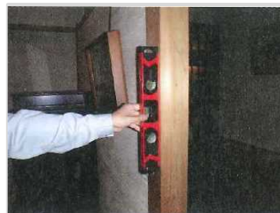
水平器による柱の傾きの計測
