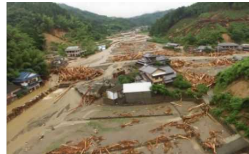
流木による被害(赤谷川、小河内川合流付近) 福岡県朝倉市
