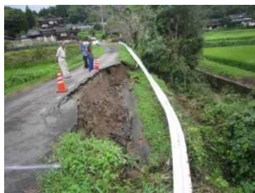
査定前着工の実施事例
