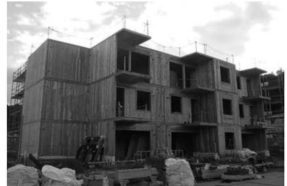
CLTパネル工法を導入することにより、工期の短縮を図るとともに、木材の利用を促進。
