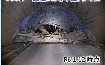
写真① 国道249号中屋トンネル
