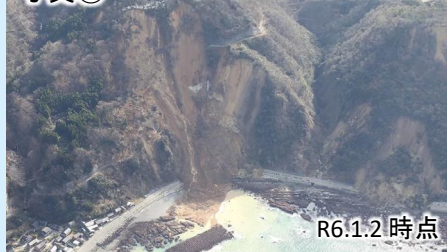
写真③ 国道249号法面崩落
