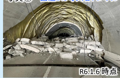
写真⑤ 国道249号大谷トンネル
