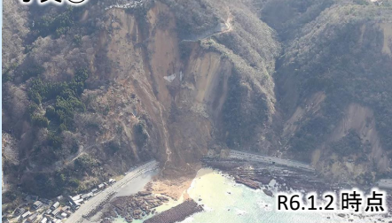
写真③ 国道249号法面崩落
