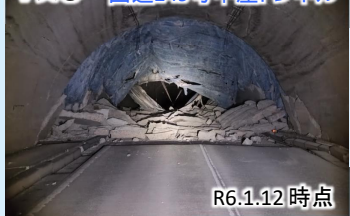
写真① 国道249号中屋トンネル
