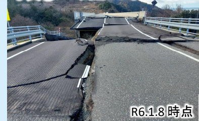
写真④ 国道249号鳥川橋
