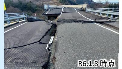
写真④ 国道249号鳥川橋
