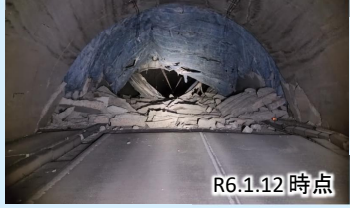
写真① 国道249号中屋トンネル
