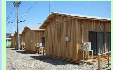
木造仮設住宅（設置例）
