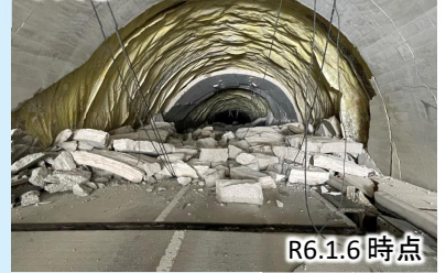
写真⑤ 国道249号大谷トンネル
