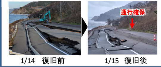
写真② 国道249号緊急復旧完了
