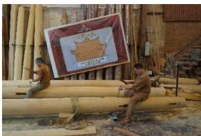
木造構造材加工状況
