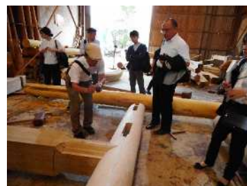
柱梁仕口加工・組立
