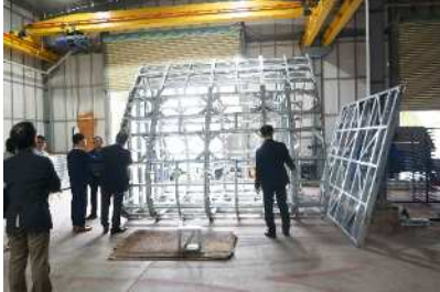
軽量鉄骨造の構造体
