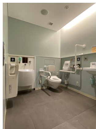
③男女共用の車椅子使用者用便房 （オストメイト用設備付）
