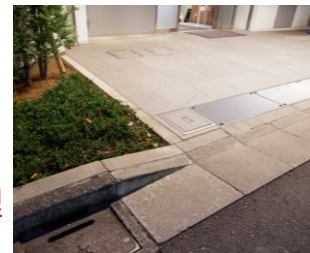
敷地内の通路と道路の境界部の縁石の切り下げ
