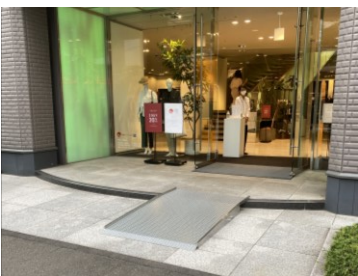
車椅子用据え置き型スロープ (特注鉄板敷:テナント側で設置)
