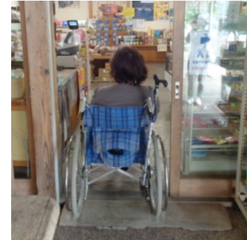
●売店出入口幅82cm(引き戸) 扉下枠部は傾斜にて段差解消
