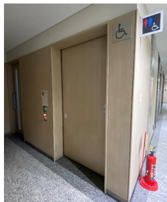
・全ての障害者を対象とした国際シンボルマークと男女共用のみの表示(便房内は大型ベッド付き)
