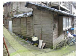
整備前の状況(城ヶ谷区)
