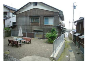
整備後の状況(城ヶ谷区)
