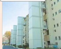
エレベータ設置
