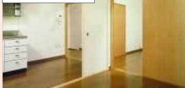
段差への配慮
