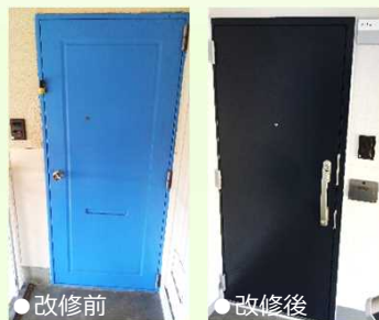
玄関扉の断熱改修
