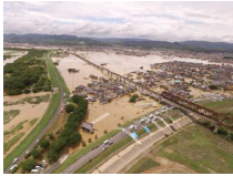
岡山県倉敷市真備町
