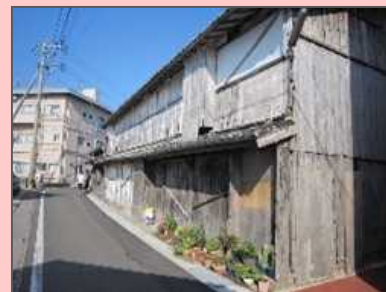
空き家の除却
