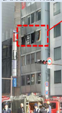
【火災建築物 外観】
