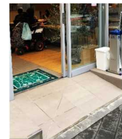
スロープの設置
