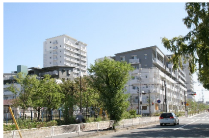
通り沿いに中低層住棟を配し、奥に細い高層住棟を分散配置し、圧迫感を低減
