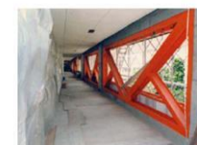
鉄骨ブレースによる壁の補強
