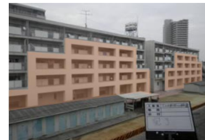
▲外付けフレーム耐震補強
