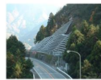
斜面崩落防止対策
