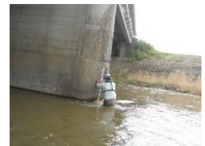
手作業による 下部工洗堀状況の計測
