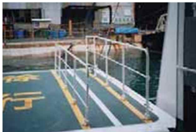
ランプ通路の手すり
