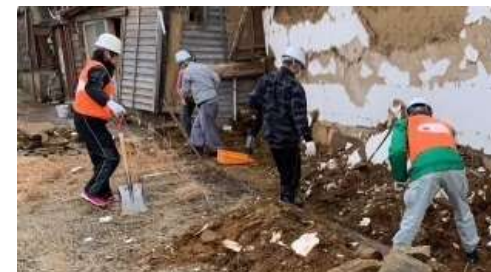
瓦礫撤去などの復旧作業
