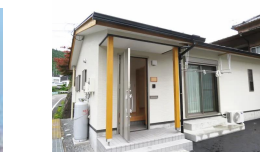
空き家の改修(お試し居住施設)
