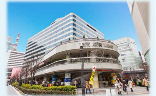
ふるさと回帰支援センター （東京交通会館内（有楽町））
