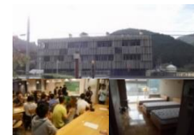
廃校を利用した交流施設
