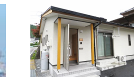
空き家の改修（お試し居住施設）
