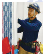
クロス工事施工中
