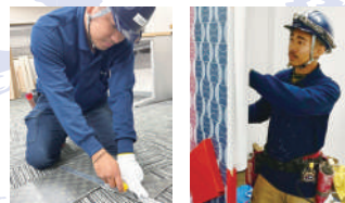
床タイルカーペット施工中
