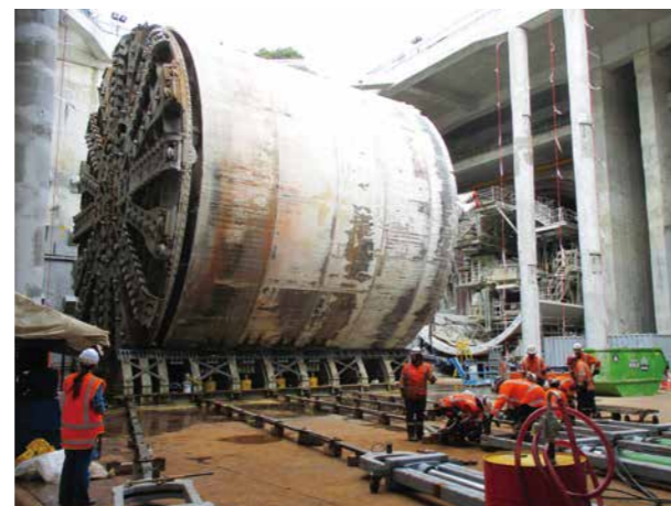
1本目トンネル掘削完了後、到達した立坑内でシールドマシンを旋回している状況/ Turning TBM inside the shaft after completion of boring the first tunnel
