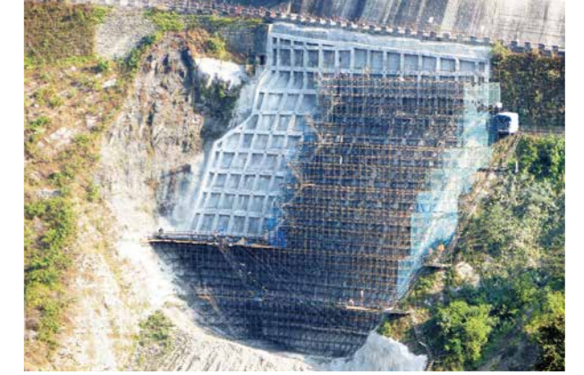
グラウンドアンカー用足場 / Scaffolding for ground anchors
