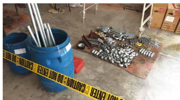
整頓された設置作業現場/A well-ordered installation work site
