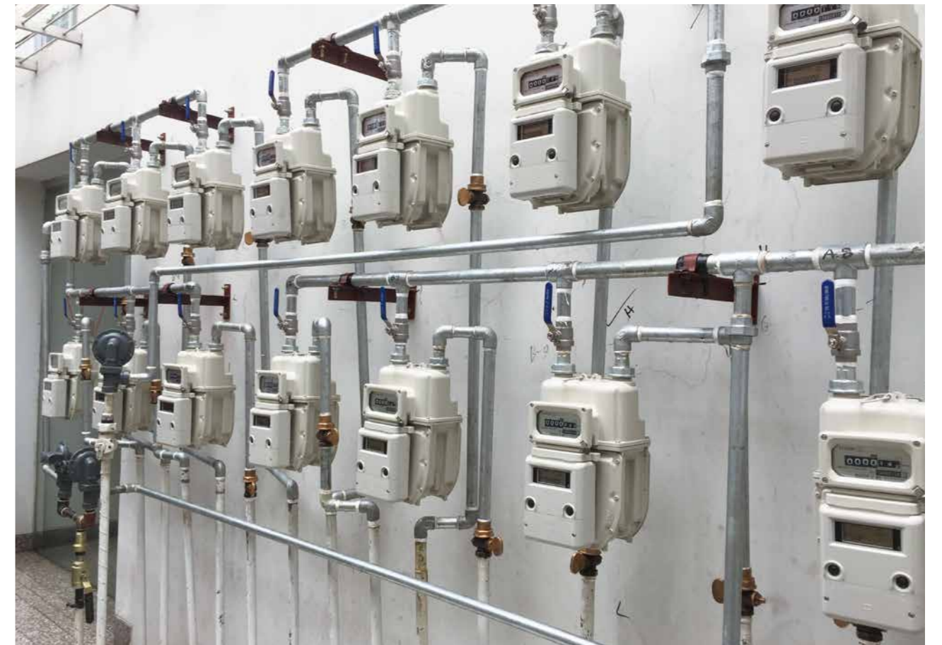
集合住宅に設置されたプリペイド式ガスメーター／Pre-paid gas meters installed at an apartment complex
