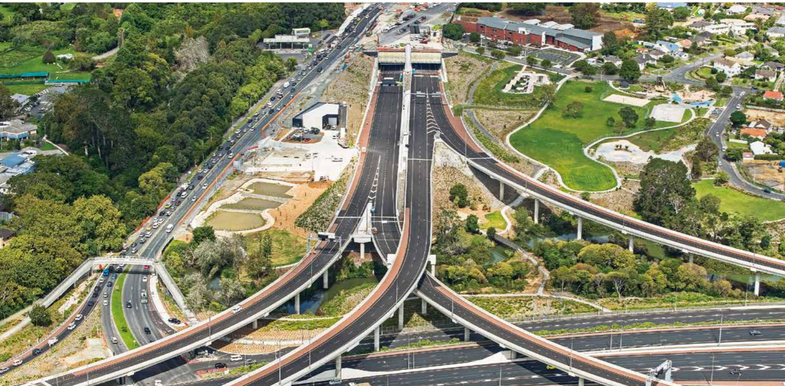
トンネル北坑口と既設高速に接続するランプ高架橋の上からの撮影 / Aerial photograph of the ramp bridge connecting the tunnel's north entrance with the existing highway
