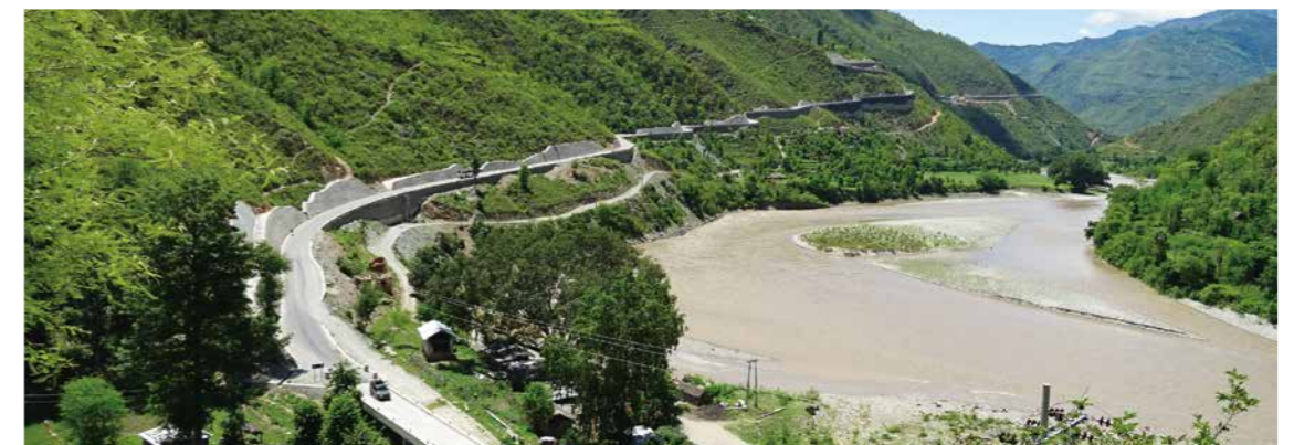
第3工区 スンコシ川沿いの区間／Section III – Section along the Sunkoshi River
