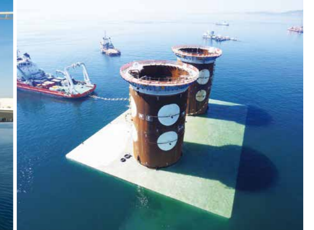
スチールシャフト搭載、ケーソン沈設／ Steel shaft installation and caisson sinking
