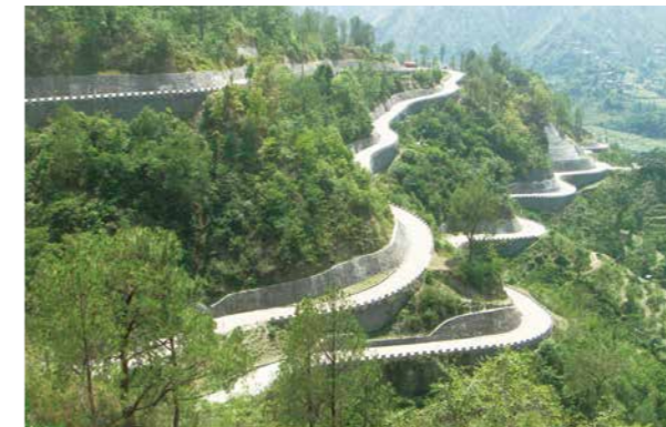
第2工区 つづら折り区間 / Section II - Switchback Section
