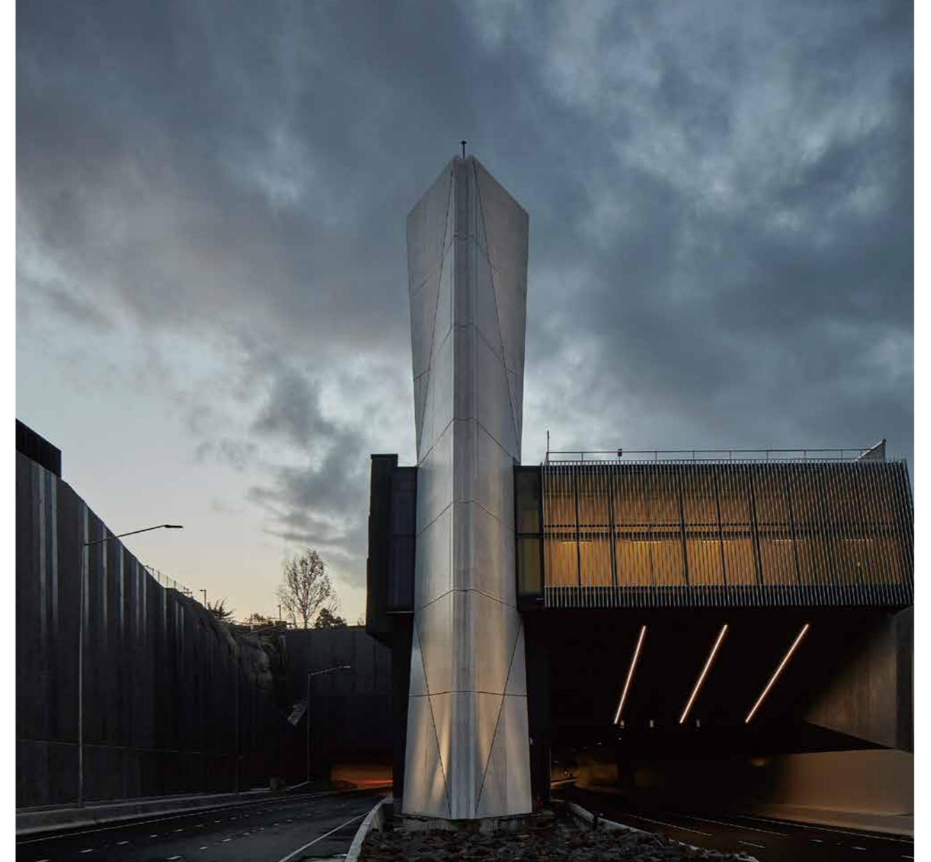
南坑口付近に設置されたトンネルの換気塔 / Tunnel ventilation stack built near the south portal
