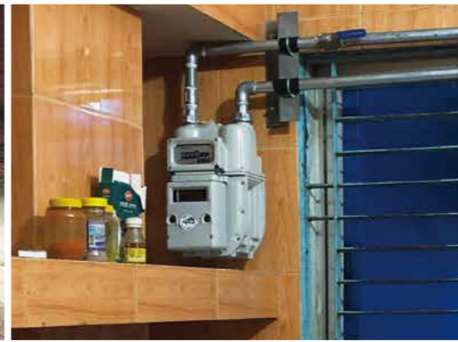
宅内に設置されたプリペイド式ガスメーター／ Pre-paid gas meter installed inside a house
