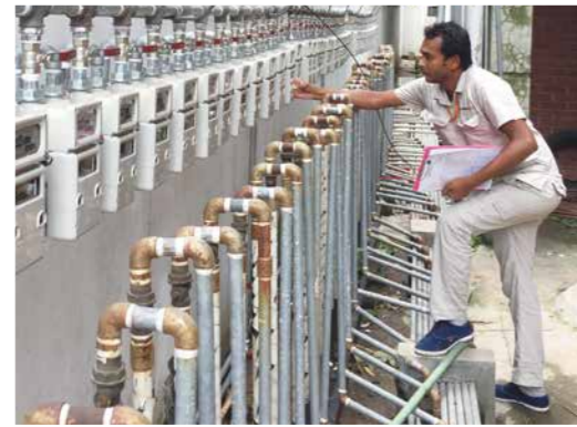
設置されたプリペイド式ガスメーターの点検／ Inspection of installed pre-paid gas meters
