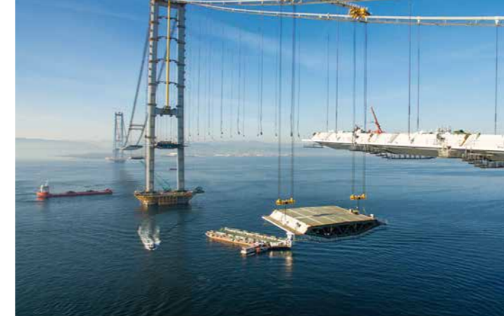
側径間と中央径間ブロックの同時架設／ Simultaneous erection of side span and main span deck segments
