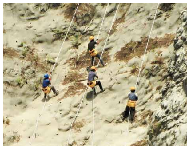
ロープワークによる法面作業の実地訓練／ Hands-on slope work training using ropework
