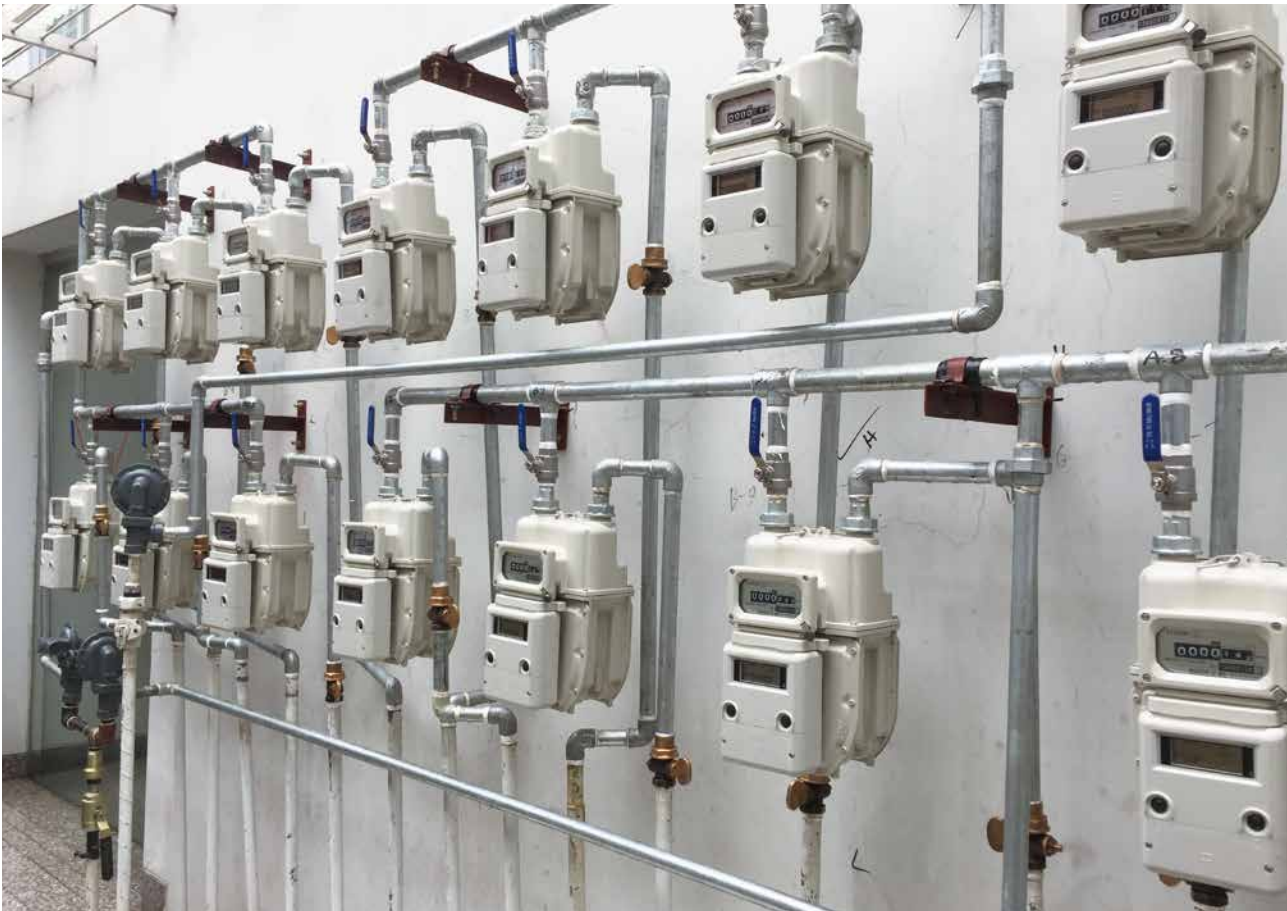
集合住宅に設置されたプリペイド式ガスメーター／Pre-paid gas meters installed at an apartment complex
