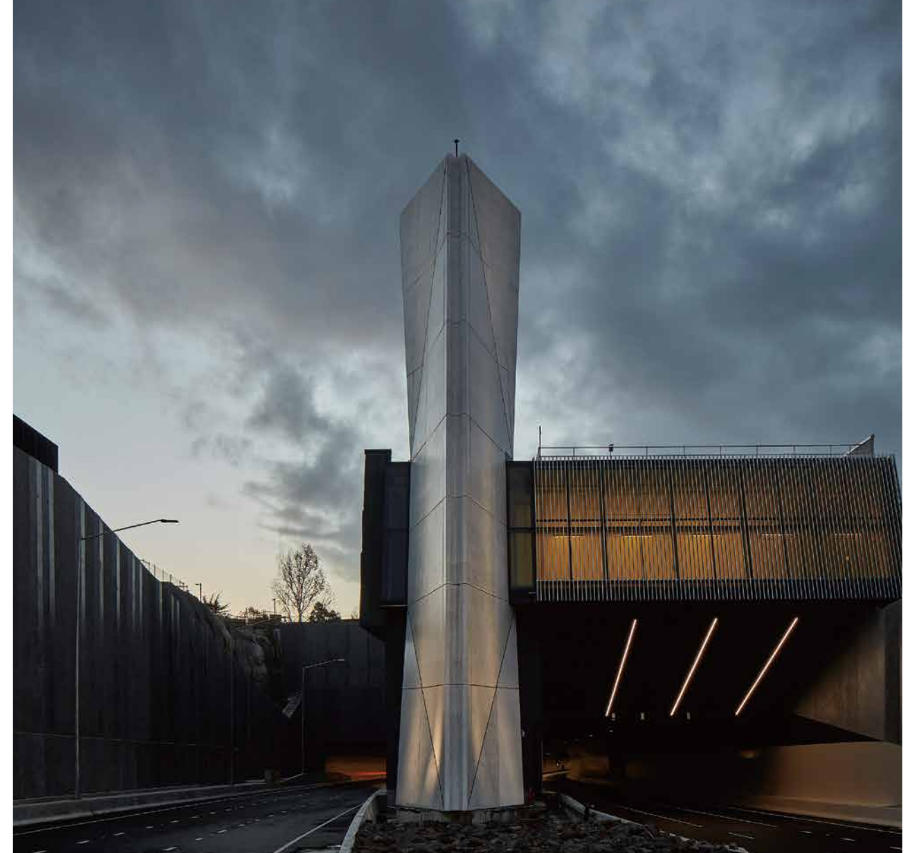
南坑口付近に設置されたトンネルの換気塔／Tunnel ventilation stack built near the south portal
