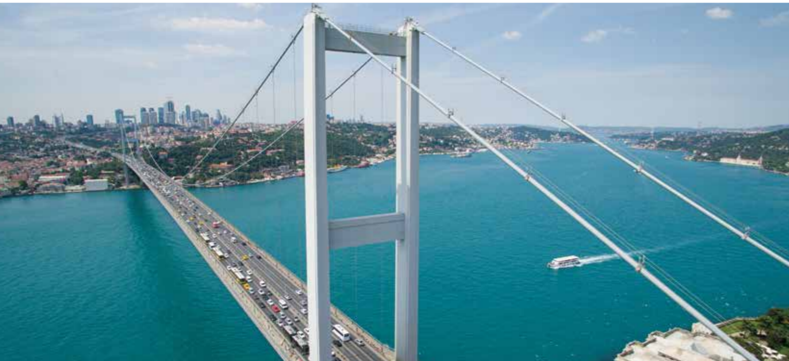
補修後の第1ボスボラス橋(斜めハンガーから鉛直ハンガーへ全量取替, 送気乾燥システムの設置, メインケーブルの補修等) / First Bosphorus Bridge after the repair (full replacement of diagonal hangers with vertical hangers, installation of dehumidification system, main cable repair, etc.)
