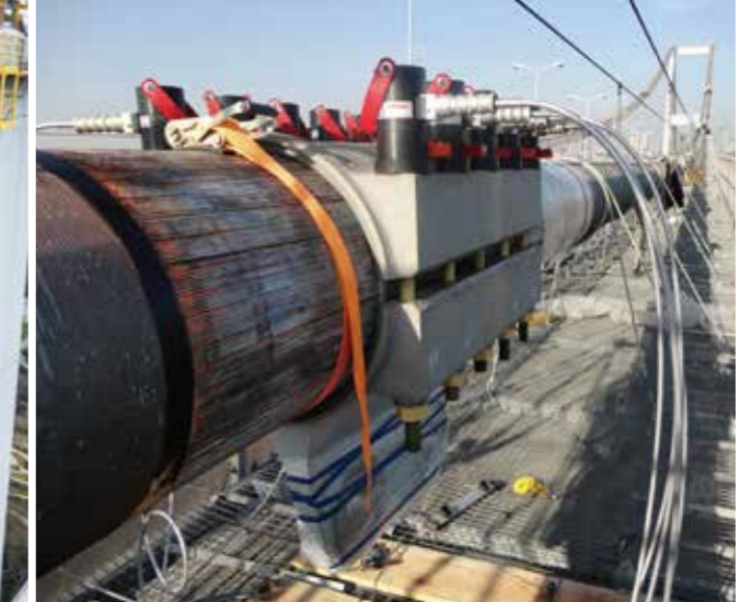
第1ボスボラス橋, ケーブルバンドボルト軸力導入状況 / First Bosphorus Bridge, Applying axial tension on cable band
