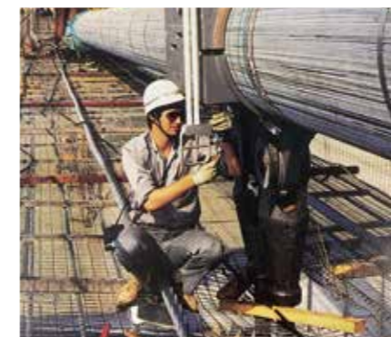
1986年、第2ボスポラス橋の建設現場／ Construction Site of Second Bosphorus Bridge
