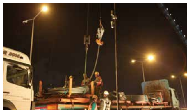
第1ボスポラス橋、夜間における鉛直ハンガーロープ取付工事／ First Bosphorus Bridge, Vertical hanger rope installation during night time
