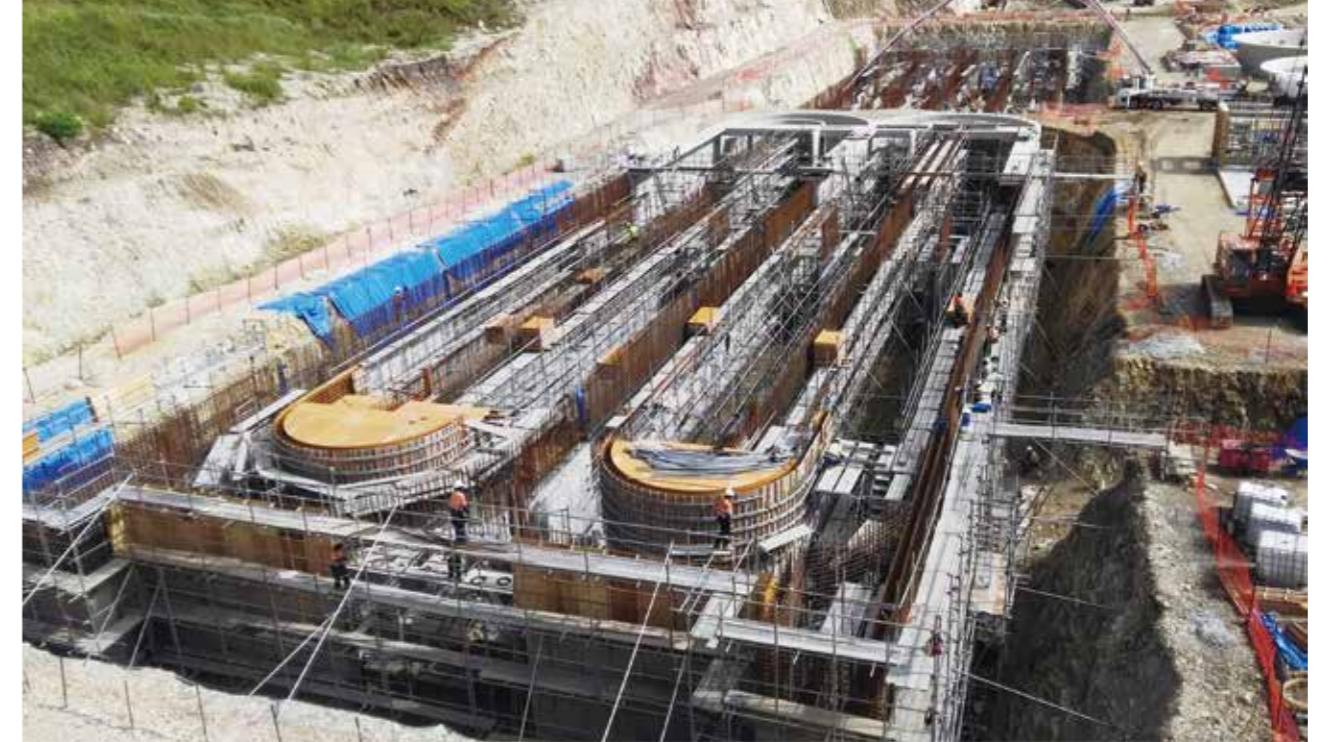
オキシレーションディッチ施工状況/Construction of the oxidation ditch
