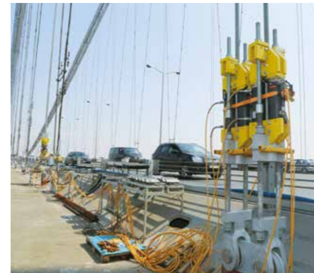
第1ボスボラス橋, ハンガーケーブル張力導入設備 / First Bosphorus Bridge, Installation of hanger cable tensioning equipment
