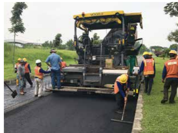
工業団地内のオーバーレイ状況 / Overlay work in industrial park
