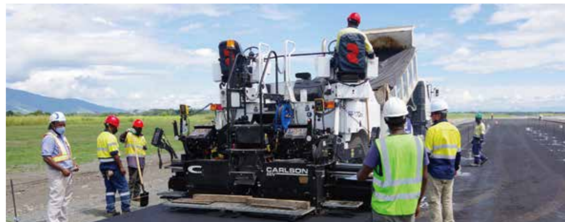
ナザブ空港再開発プロジェクトでの施工管理状況/Management of the construction work in the Nadzab Airport redevelopment project
