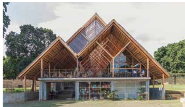
建物正面。手前にはカフェやショップなど現地の素材を生かした商品を販売するテナントが入る／ View of the facility from the front. It features cafes, shops, and other tenants selling products made from local ingredients and materials
