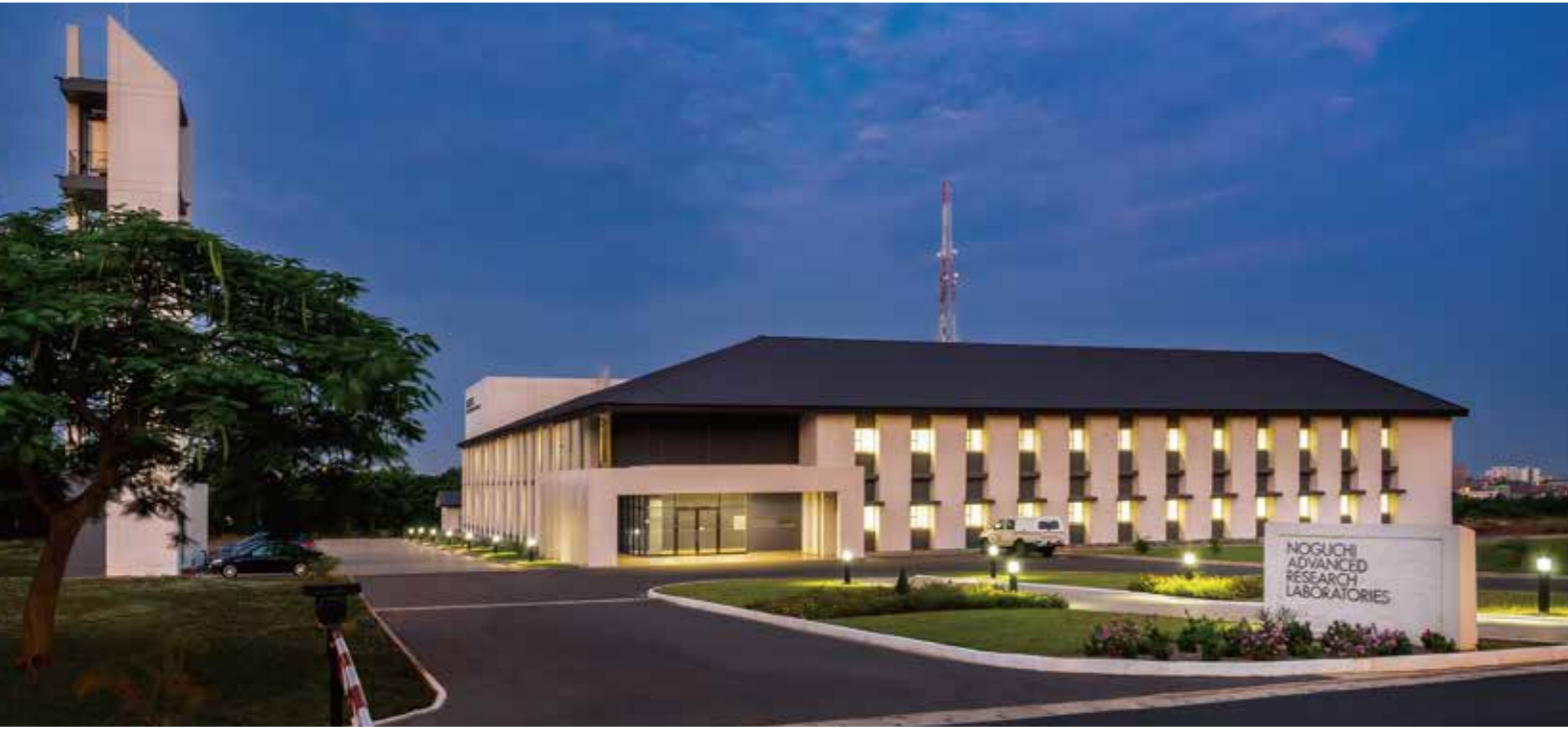
正面外観写真 / Front view
