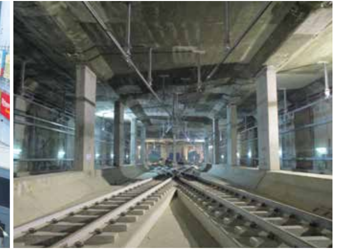
ブンデランハイ駅の南側に設置された地下軌道分岐／ Underground scissors crossing at south side of Bunderan HI Station
