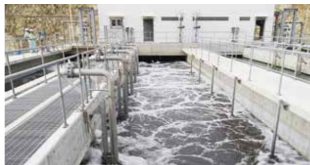
オキシデーションディッチ運転状況/ Operation using the oxidation ditch process
