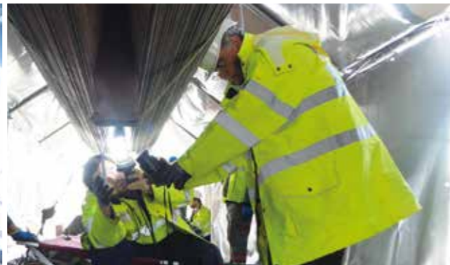
第1ボスポラス橋、主ケーブル開放調査／ First Bosphorus Bridge, Main cable inspection
