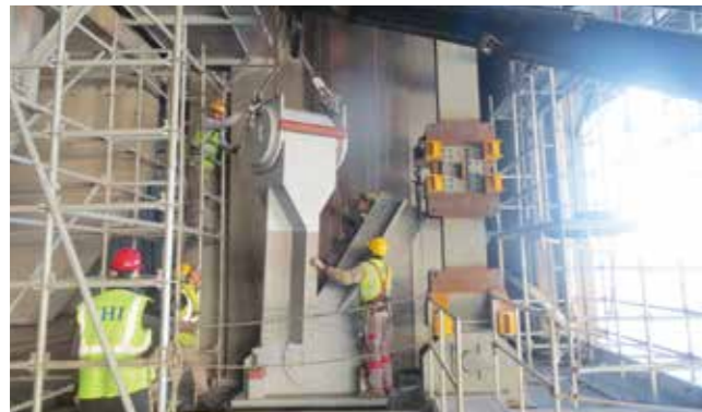
第2ボスポラス橋、ロッカーリンク取替／ Second Bosphorus Bridge, Rocker link replacement
