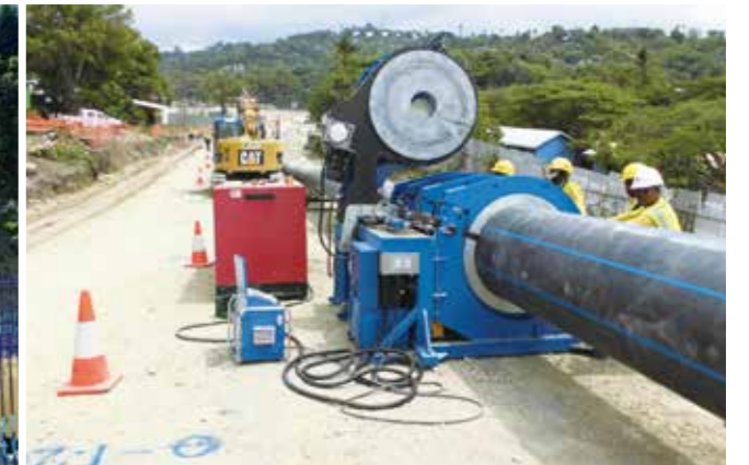
高密度ポリエチレン管 (HDPE管) 施工状況/ Installation of high-density polyethylene pipes (HDPE)
