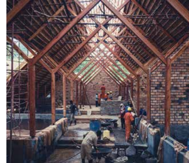
現地の大工が現場で溶接された金物とユーカリ材を組み合わせていく／ Local carpenters combining hardware (welded on site) with eucalyptus wood
