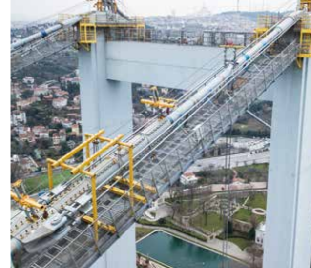
第1ボスボラス橋, 主ケーブル補強工事 / First Bosphorus Bridge, Main cable reinforcement
