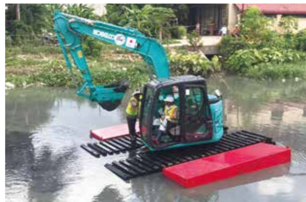
水陸両用掘削機による浚渫工事(カンボジア) / Dredging using amphibious excavators (Cambodia)
