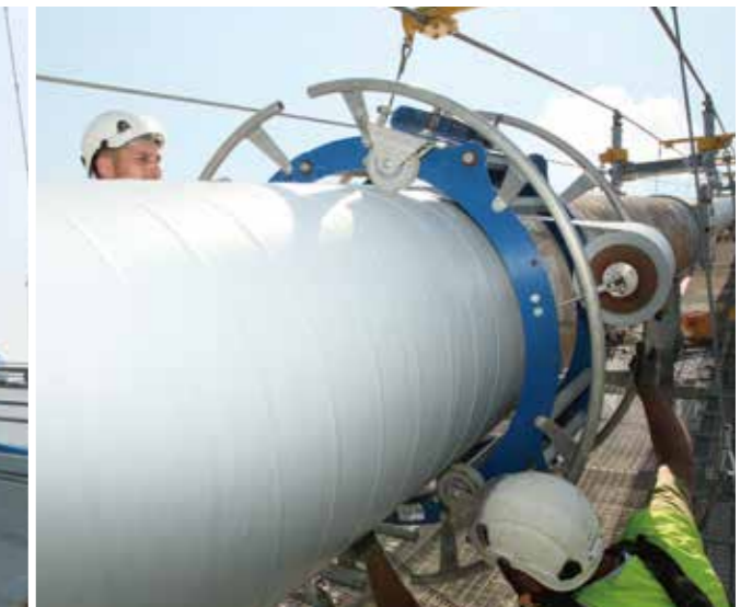
第2ボスボラス橋, 弾性シール材施工状況 / Second Bosphorus Bridge, Application of elastomeric wrapping
