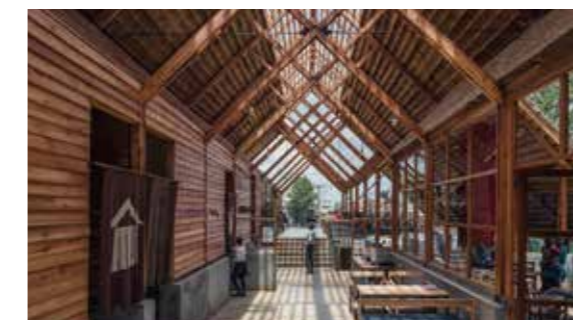
内観。ユーカリの架構が大屋根を支えている／ Interior. Eucalyptus beams supporting the large roof
