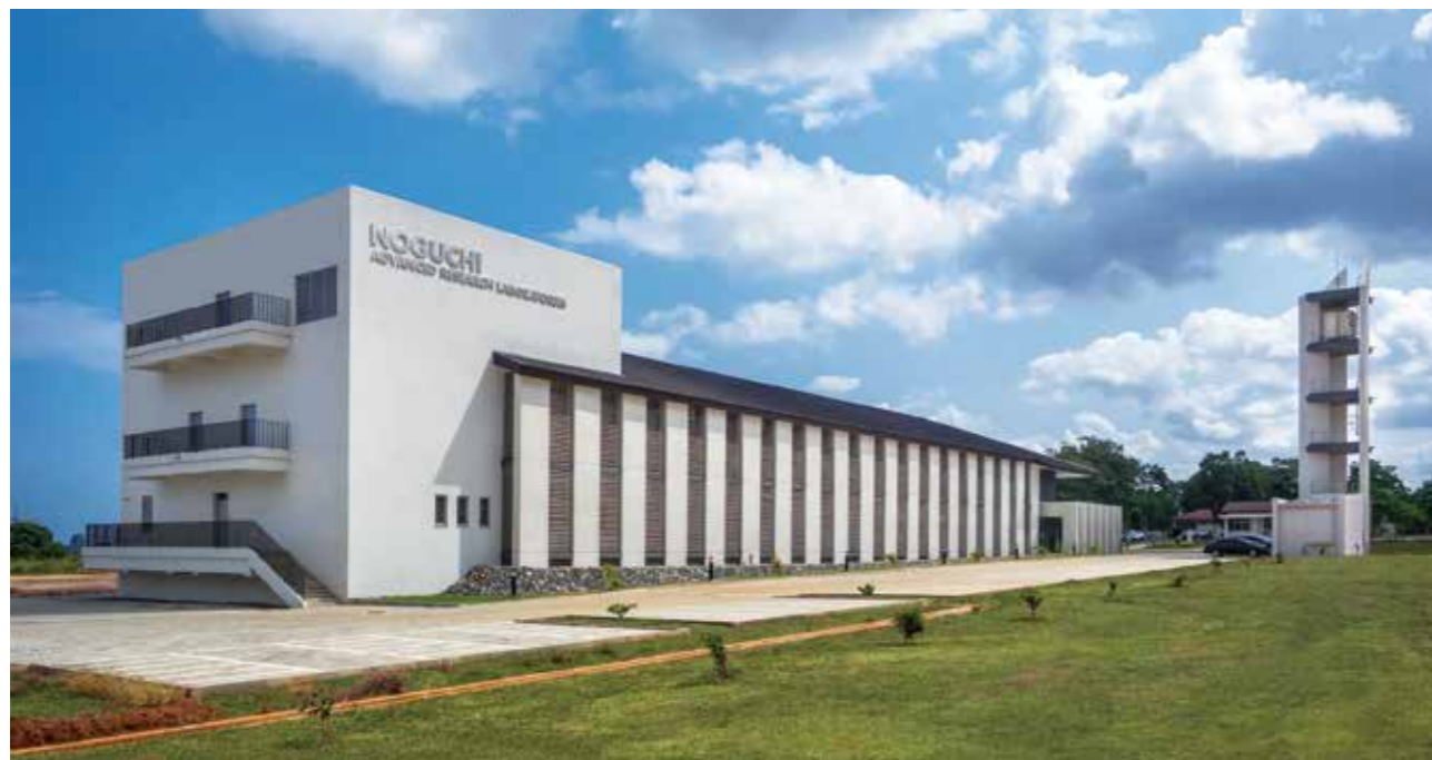
北面外観写真「NOGUCHI」のロゴが大きく掲げられている／North side view. A large “NOGUCHI” logo can be seen
