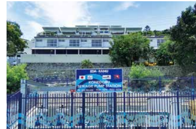
コネドブ下水ポンプ場/ Konedobu sewage pump station
