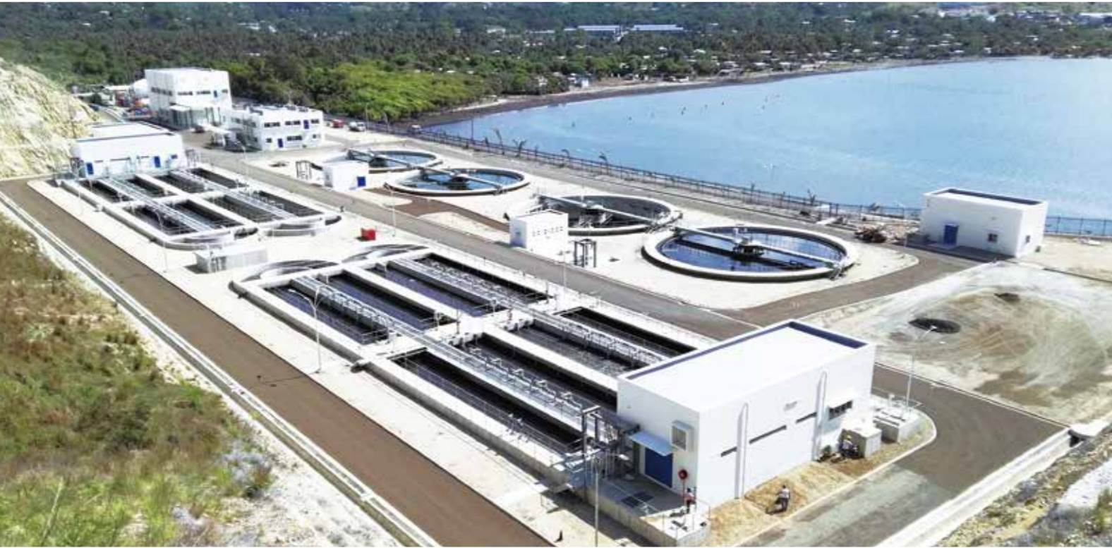
ジョイスベイ下水処理場完成写真/Completed the Joyce Bay sewage treatment plant
