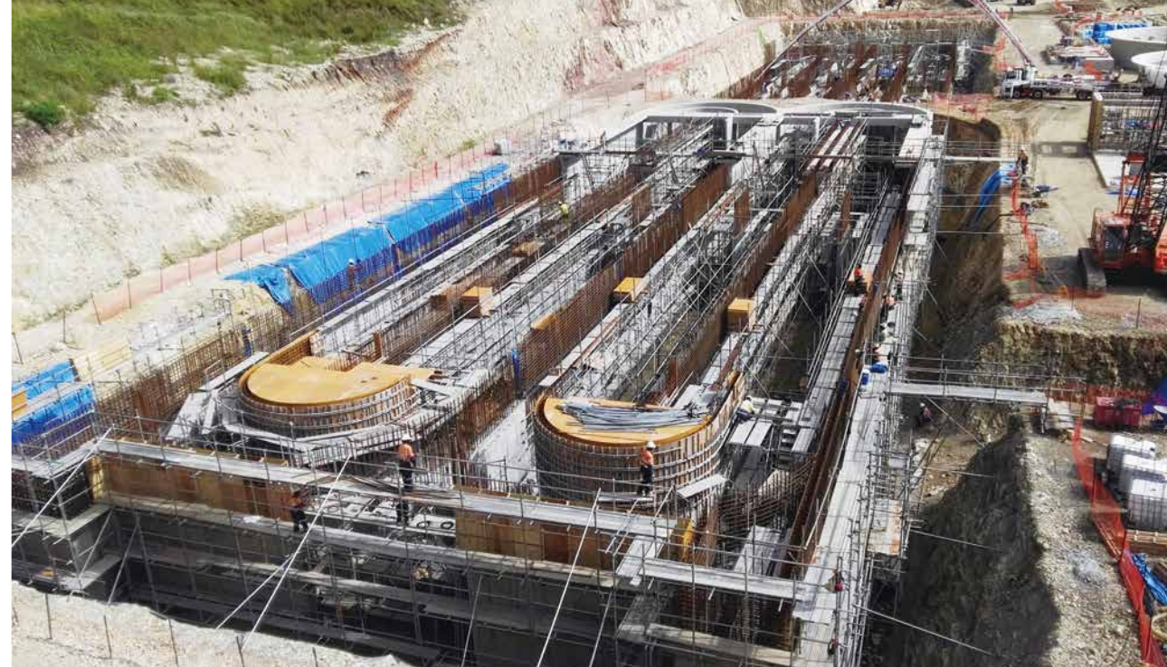
オキシデーションディッチ施工状況／Construction of the oxidation ditch
