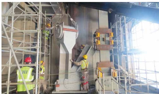
第2ボスポラス橋、ロッカーリンク取替／ Second Bosphorus Bridge, Rocker link replacement
