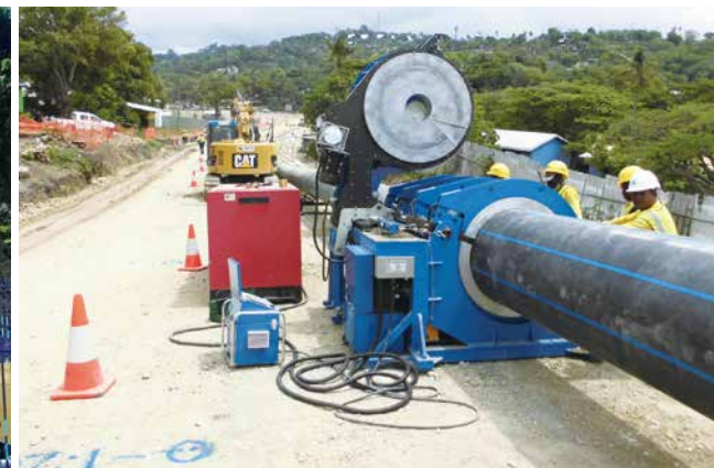
高密度ポリエチレン管 (HDPE管) 施工状況／ Installation of high-density polyethylene pipes (HDPE)
