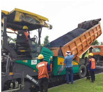
工業団地にて、リサイクルアスファルトの試験施工／ Test application of recycled asphalt in an industrial park
