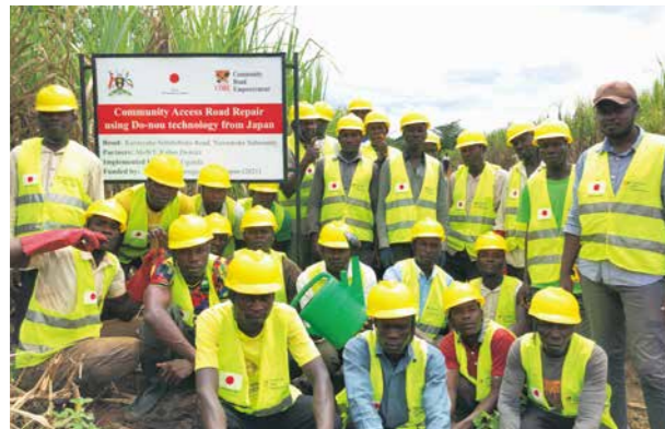
土のう工法による道直し後に設置された看板と参加者(ウガンダ) / Signboard put up on a road repaired with the Do-nou technology and trainees (Uganda)
