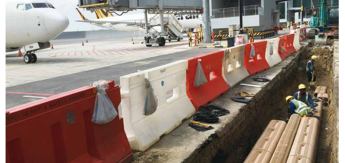
シンガポールチャンギ国際空港 施工写真 / Construction of Singapore Changi International Airport
