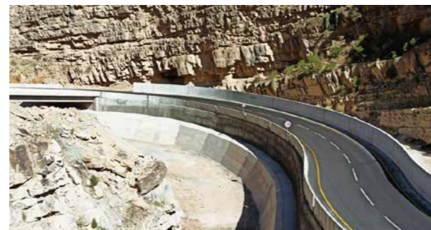
自然災害に対する強靭化が図られた既存国道／Existing national highway with enhanced resilience to natural disasters
