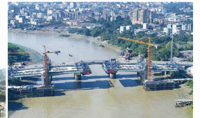
PCエクストラード橋の張出架設工事／ Overhang erection for the PC extradosed bridge
