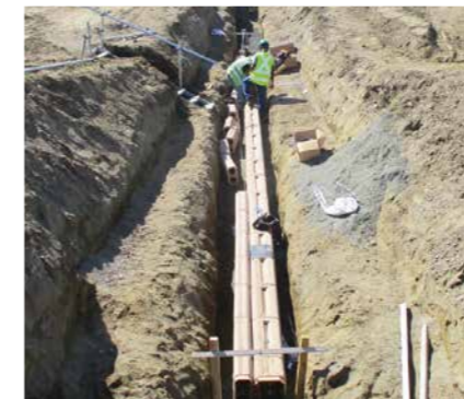
パプアニューギニア ナザブ空港整備事業 施工写真 / Redevelopment of Nadzab Airport, Papua New Guinea
