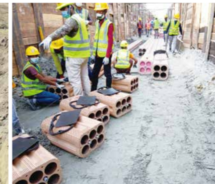
バングラデシュ ハズラット・シャージャラル国際空港 施工写真 / Construction of Hazrat Shahjalal International Airport, Bangladesh
