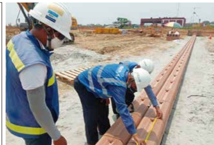
バングラデシュ ハズラット・シャージャラル国際空港 施工写真 / Construction of Hazrat Shahjalal International Airport, Bangladesh
