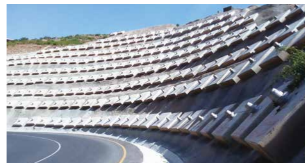
ECFストランドを使用したグラウンドアンカー／Ground anchors using ECF strands
