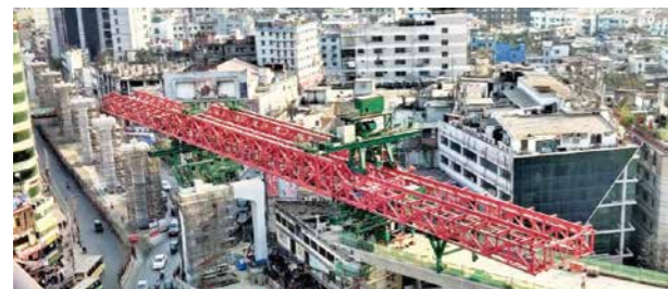
現在施工中のダッカ都市鉄道6号線建設工事(バングラデシュ)／ Dhaka City Railway Line No. 6 construction, currently in progress (Bangladesh)
