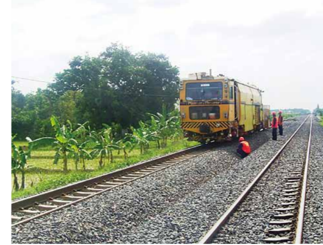
ジャワ北線複線化工事での機械化施工導入(インドネシア) / Introduction of mechanized construction for Java North Line double-tracking works (Indonesia)
