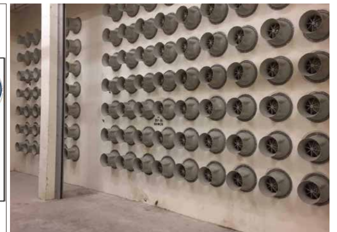
ベドックノース駅の防爆設計が施された壁／ Blast valves in wall at Bedok North Station
