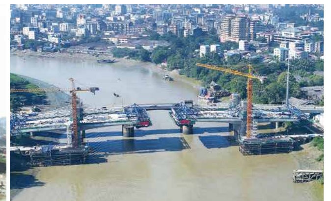
PCエクストラードス橋の張出架設工事／ Overhang erection for the PC extradosed bridge
