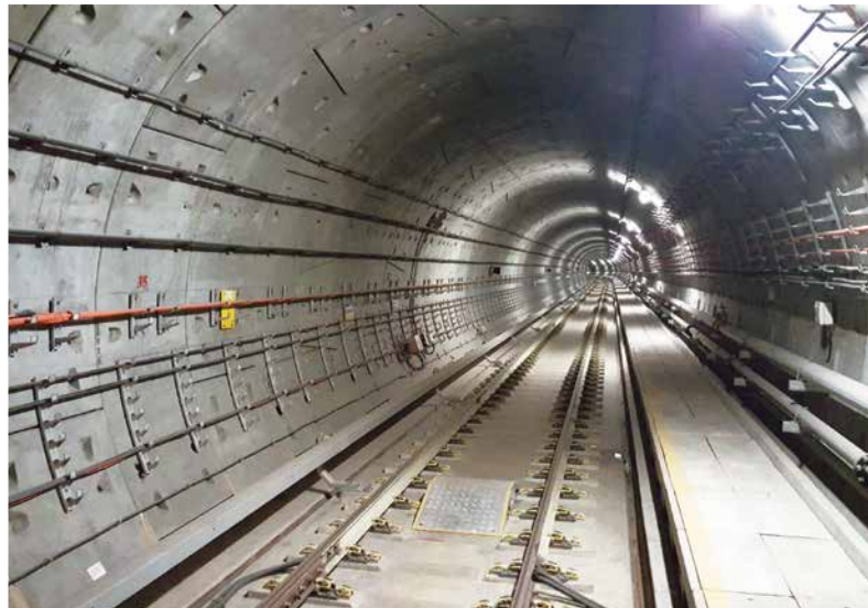
高度な管理ノウハウにより掘進されたシールドトンネル／ Tunnels bored by TBMs with advanced management knowhow
