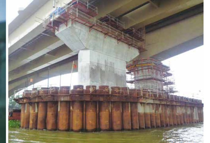
新橋及び既存橋を一体化した鋼管矢板井筒基礎／ Steel pipe sheet pile foundation integrating new and existing bridges
