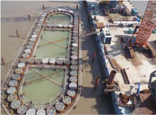
鋼管矢板井筒基礎工法(ベトナム ビンカイン橋) / Steel pipe sheet pile well foundation method (Binh Khanh Bridge)
