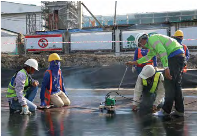
JICA普及・実証・ビジネス化事業において、現地作業員に遮水シートの熱融着技術を指導／ Training to local wokers about welding method for impermeable sheet in the JICA survey
