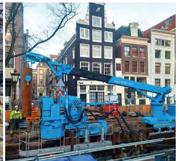
街路樹を撤去せずに施工をしている様子／ Piling without removing roadside trees
