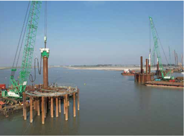
油圧パイプロと油圧ハンマを使用して施工(バンガバンドゥ鉄道橋工事) / Construction using hydraulic vibro hammers and hydraulic hammers (Bangabandhu Railway Bridge construction)
