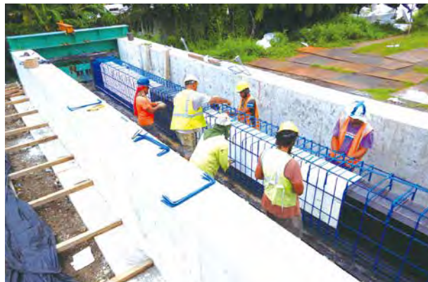
サモア企業による現地での桁製作(主桁鉄筋組立)／ Girder production (rebar arrangement work) by the local contractor in Samoa
