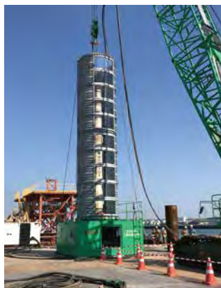
油圧ハンマの騒音防止装置を使用した鋼管杭の打設状況 (ハンマと杭を装置で覆った状態で施工中)／ Placement of steel pipe piles using a hydraulic hammer noise control system (hammer and piles covered by the system)
