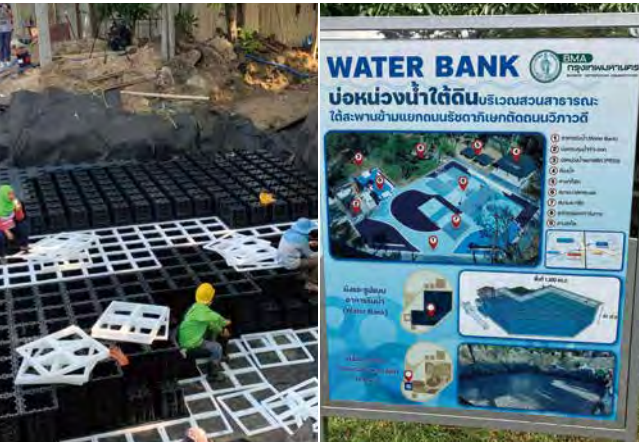
リモートによる施工指導でバンコク都の公園再整備事業 (Water Bank Project)へPRSSを納入／ Constructed with remote construction instruction (BMA Water Bank Project)
