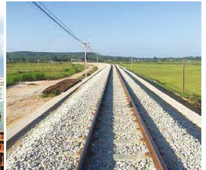
日本から輸入したレール(50N)を使用し軌道改修を実施／ Track rehabilitation using rails (50N) imported from Japan
