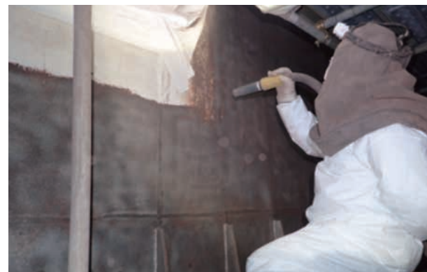
環境を考慮した日本の循環式エコクリーンプラストを採用することにより 研磨材の97%削減を達成した／ Adoption of environmentally Japanese recirculating eco-clean blasting system has achieved a 97% reduction in abrasives
