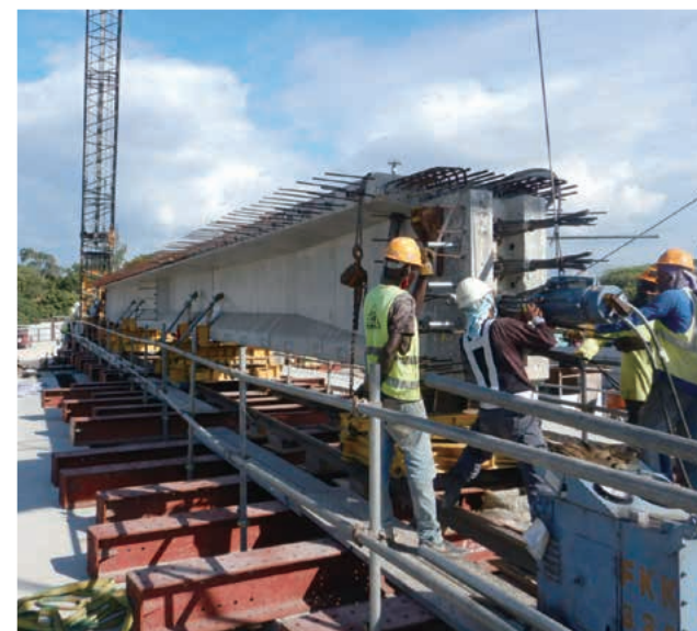
クロワ・デ・ミッション橋梁 PC上部工事 (製作) プレキャストセグメントの接合及びプレストレス導入 / Croix des Missions Bridge: PC Superstructure Work (Fabrication) Joining of pre-cast segments and Prestressing
