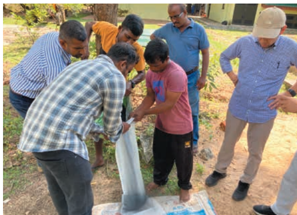
現地スタッフによる消耗部材(活性炭)交換の様子(メンテナンス作業指導)／ Local staff replacing consumables (activated charcoal) (guidance on maintenance work)
