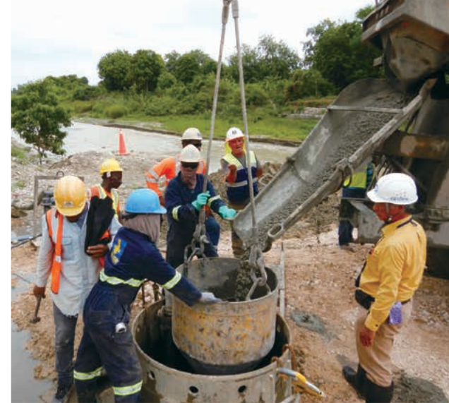
新線橋梁 P1橋脚基礎工事 トレミー工法による場所打ち杭のコンクリート打設 / Route Nueve Bridge: P1 Pile works Casting concrete by Tremie-pipe method.
