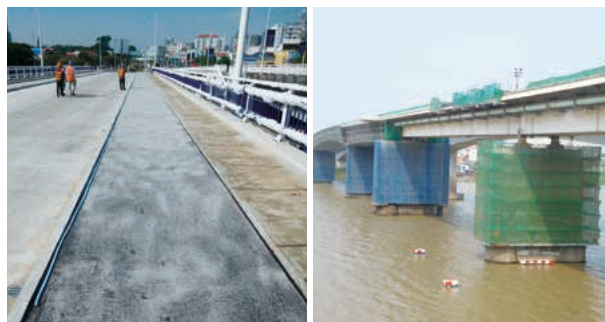
上部工：鋼桁再塗装、SFRC舗装、防水・排水工、高欄などを施工／ Substructure: Cracks repair and protection, etc. 下部工：既存橋脚のクラック補修・表面含浸保護を行った／ Substructure: Cracks repair and protection, etc.
