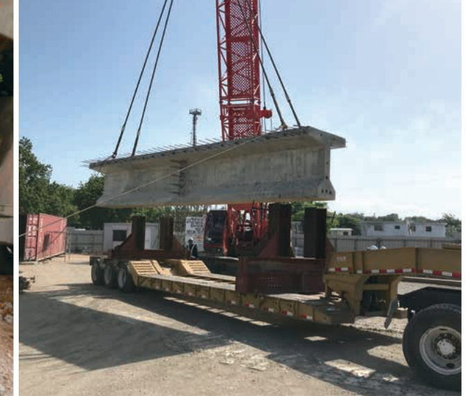
クロワ・デ・ミッション橋梁 PC上部工事 (運搬) セグメントに分割されたプレキャストPC桁の積込み / Croix des Missions Bridge: PC superstructure work (Transport) Loading of segmented precast PC-beam
