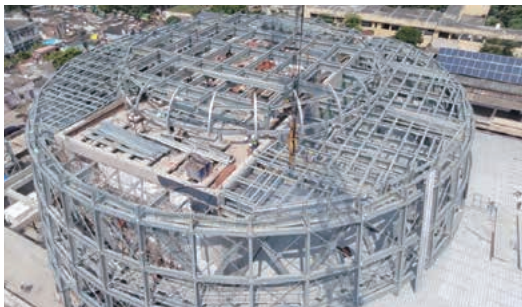
鉄骨とアルミパネルルーバーで構成されるフライタワー Fly tower made up of steel frames and aluminum panel louvers.
