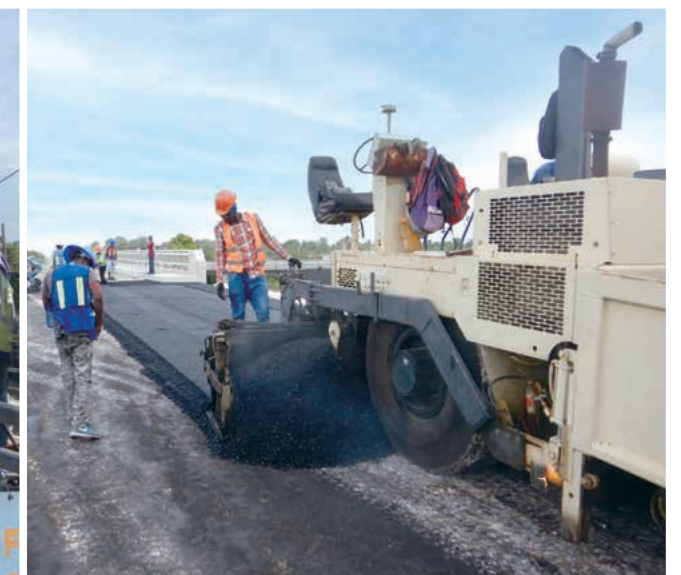
新線橋梁 アスファルト舗装工事 アスファルトフィニッシャーによるアスファルトコンクリートの舗設 / Route Nueve Bridge: Asphalt pavement works Asphalt works by asphalt finisher
