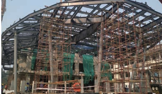
ホール上部の大屋根とエントランスの大きな庇の工事を確実に行うため、 施工段階ではBIMが活用された BIM used in the construction stage to ensure the smooth installation of the large roof on top of the hall and the huge eaves of the entrance.
