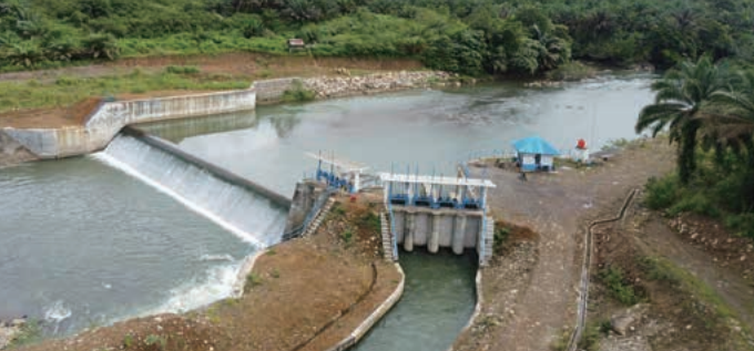
2023年11月より商業運転を開始したトンガル水力発電所(取水堰・取水口)／ Tongar Hydro power plant started commercial operation in November 2023(Weir and Intake)
