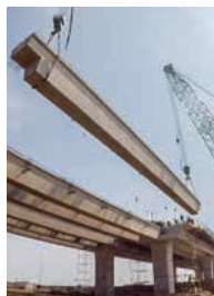
プレキャストU字桁 架設状況／ Precast U-shaped girder: Erection
