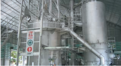
JICA普及実証事業にて設置した乾溜ガス化焼却装置GB型。 一日3トンの感染性廃棄物を無害化している／ Dry distillation gasification combustion system model GB installed for JICA's demonstration project; the system detoxifies 3 tons of infectious waste a day.
