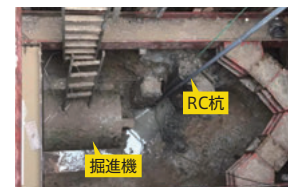
RC柱←立坑にて撤去
