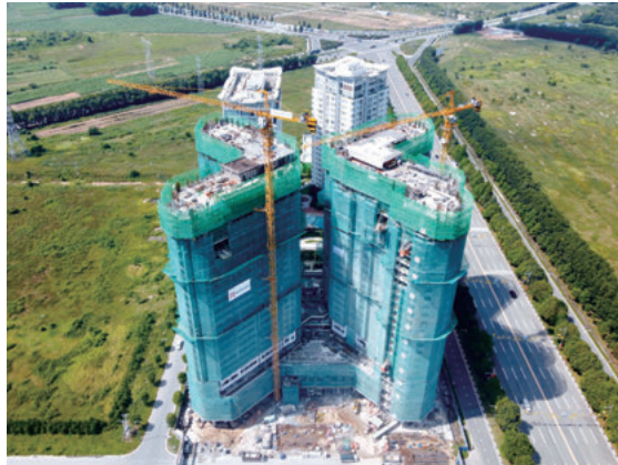
SORA gardens II工事中写真
