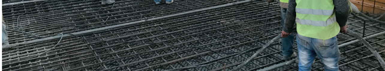
配水池スラブコンクリート打設状況
