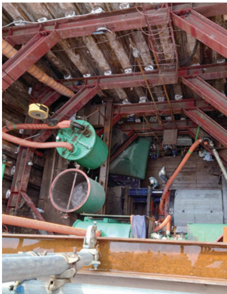
ホーチミン市の地下10mに推進工法にて下水管路を埋設 発進立坑下で推進管を油圧ジャッキにて地中へ圧入
