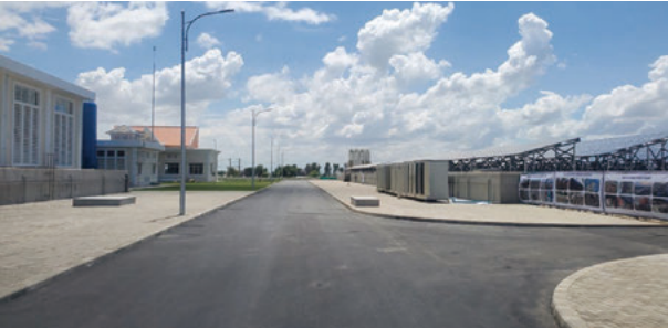
カンボジア プノンベン浄水場整備工事（に伴う管理道路舗装工事）
