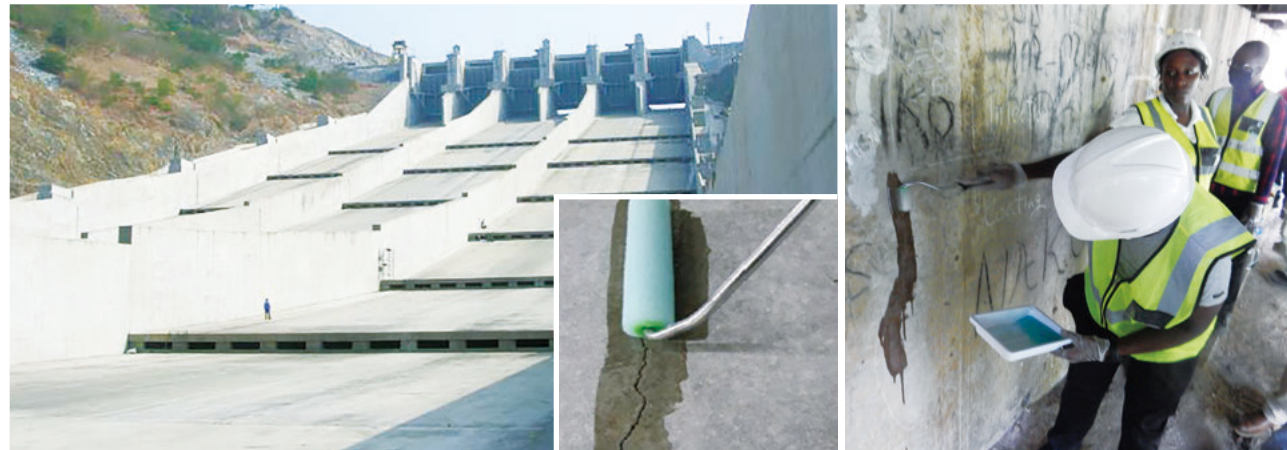
フィリピンのサンロケダムで建設中の余水路のひび割れを数千メートル補修
