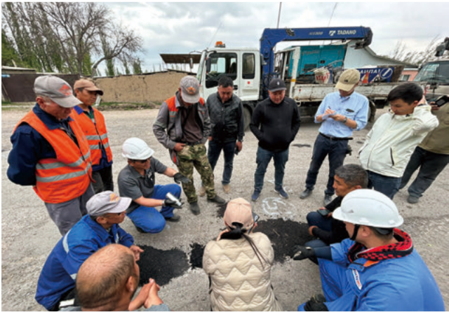
施工技術移転に伴う質疑応答の状況 （キルギスのMOTC傘下の道路公社DEP954および近隣DEPのエンジニア・作業員）
