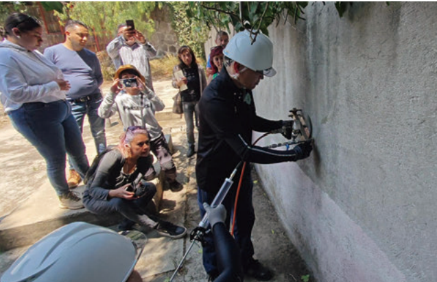
メキシコシティー市役所職員に対するひび割れ注入のデモンストレーションを実施
