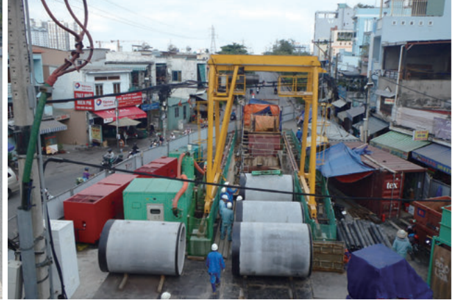
推進工事施工状況（発進基地全景）
