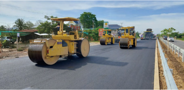
カンボジア国道5号線の舗装状況（転圧状況）－ホットジョイントで2車線の舗設－
