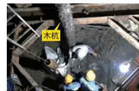
木杭←立坑築造して抜去
