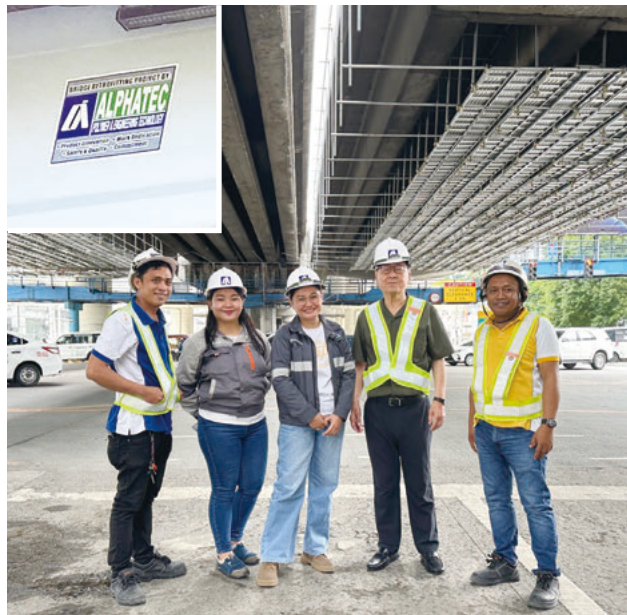
劣化したマニラ市内橋梁のひび割れを浸透性エポキシ補修剤アルファテック380で補修後に炭素繊維で補強
