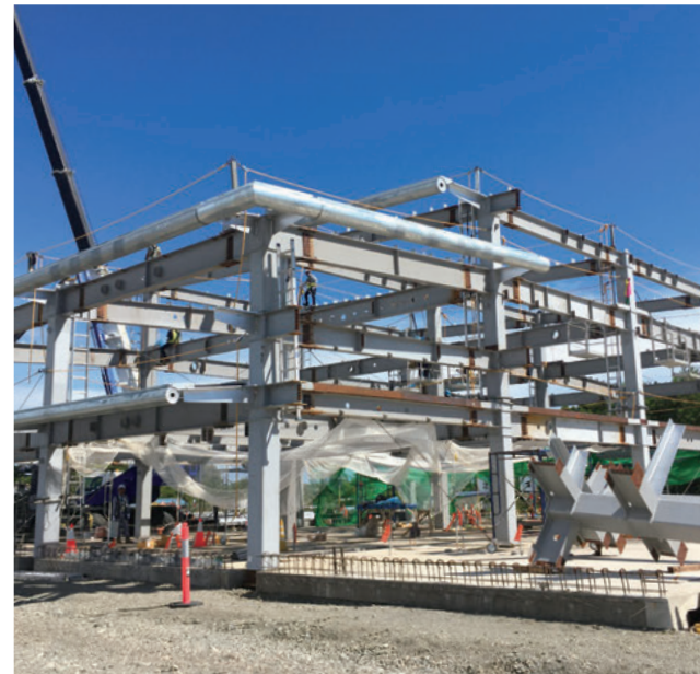
新国際線出発ターミナルビル鉄骨建方工事の様子
