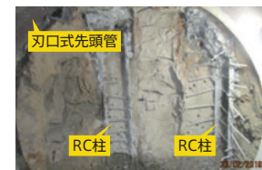
RC柱←刃口式推進を行い地下から撤去
