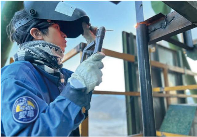
JICAの中小企業支援事業「キルギス国 全天候型舗装補修材による道路維持管理」の事例 （製造技術移転のためのアスファルトプラント改修状況）
