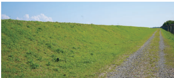
空港敷地内に建設した延長約600mの堤防
