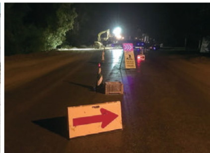
夜間配管工事エリアにおいての安全対策
