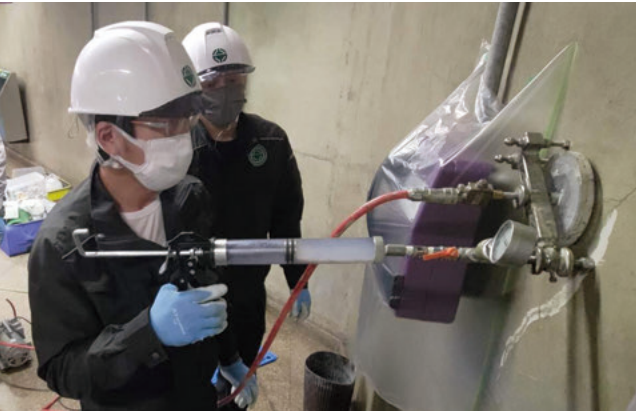
ブラジルサンパウロ市ルース駅にて駅舎壁のひび割れ(ひび割れ幅0.1mm)に自己治癒材料を注入し、ひび割れ補修を実施
