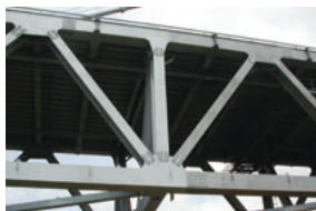
再塗装施工中のマタディ橋 (左半分が再塗装済)
