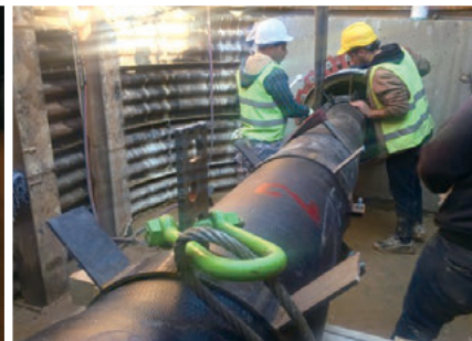
推進工事力所での送水管挿入状況
