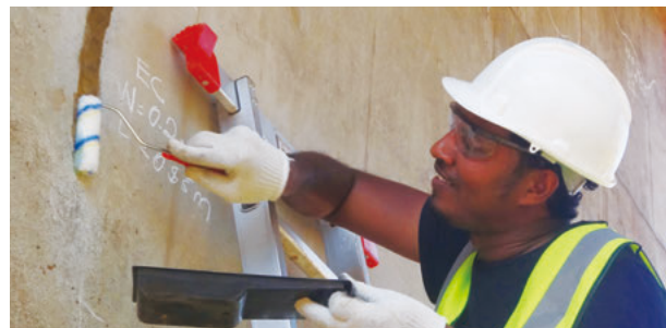
ザンビアでのアルファテック380による橋梁のひび割れ塗布補修状況
