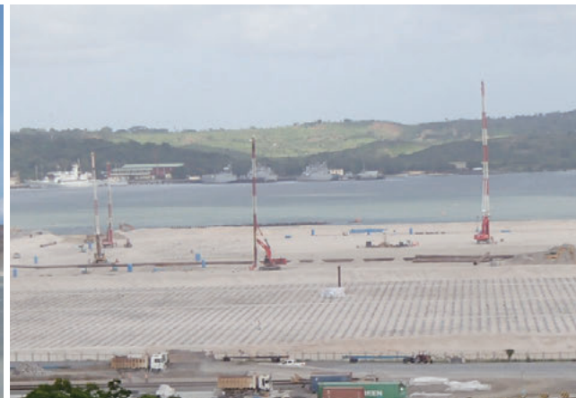
PVD打設状況。軟弱粘土地盤に425万㎡のPVDを施工し、コンテナヤードの圧密促進を図った
