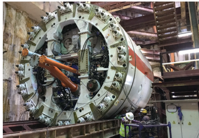
泥水式シールドマシンの組立て
