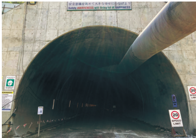
二次覆工コンクリートへ採用されたネパールのナグドゥンガ・トンネル建設事業
