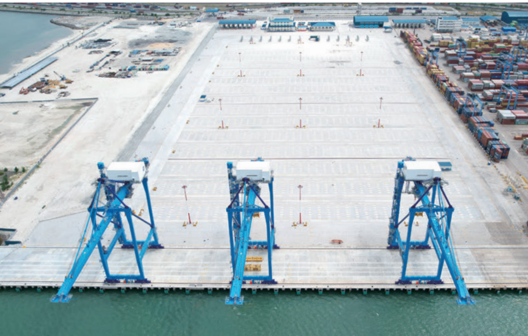
ケニア初の軟弱粘土地盤上に埋立て方式によるコンテナターミナル
