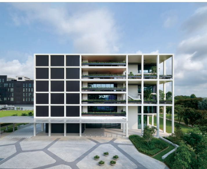
構造アウトフレームに包まれスケルトン・インフィルに徹したリビングラボ
