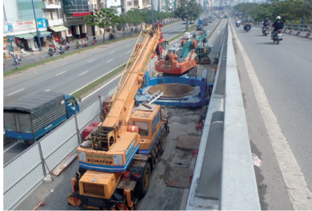
立坑工事施工状況（鋼製ケーシング立坑：変更対象）
