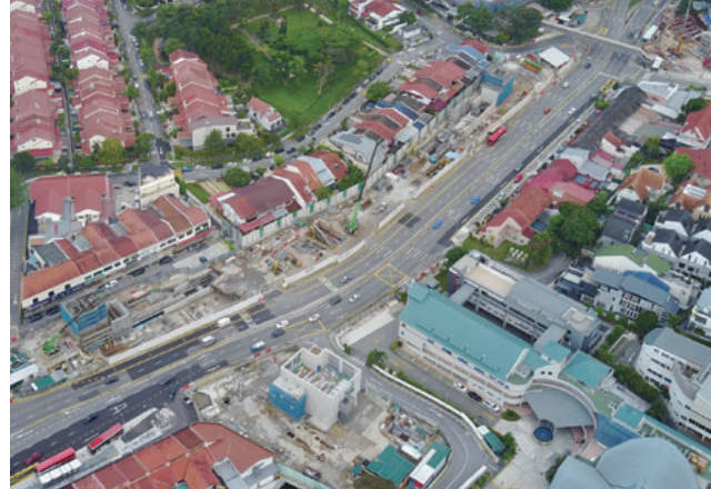
狭隘な施工ヤードでの逆巻き工法による道路直下の地下鉄駅の構築
