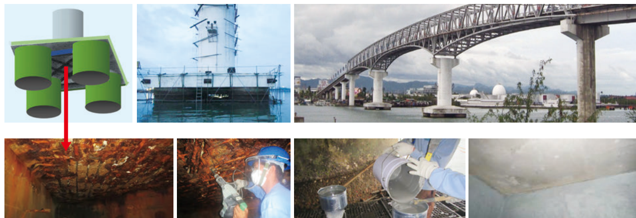
フィリピンのマクタンマダウ工橋は1973年築、塩害で劣化した橋脚を締切用の鋼矢板等を設置せず、干潮差を利用し水中硬化エポキシグラウトで補修
