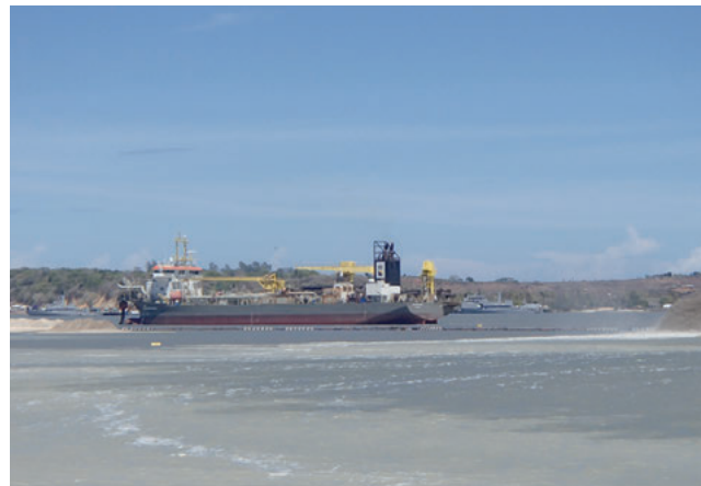
インド洋の海砂300万㎡をトレーリングサクシジョンホッパー浚渫船で急速施工による埋立
