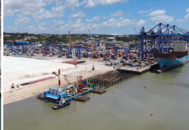
自社所有の多目的起重機船で鋼管杭を打設。パイルキーパーを使用し、50mの長尺杭を高精度で施工
