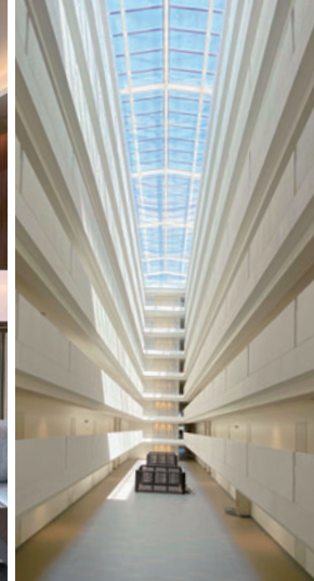
吹抜の熱溜まり解消のために、2階床下に二重スラブの「風道」を設置し、CFDシミュレーションで検証した新たな自然換気システムを試みた。工事中には、資材搬入開口として利用し効率的に工事用資材を供給すると共に、吹抜の出来映えに大きく影響する廊下の手すり壁面通りと直角精度の重点管理を実施。
