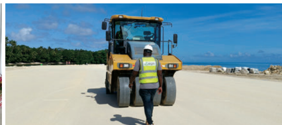
サンタクルズ空港プロジェクト現場での業務の様子
