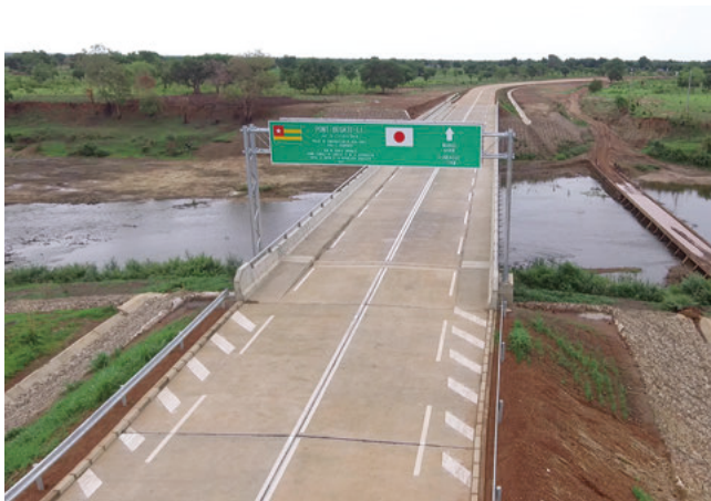
コンクリート舗装へ採用されたトーゴ共和国のカラ橋及びクモンゴ橋建設計画
