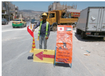
市街地の配管工事エリアにおいて、工事用車両出入口での安全管理(誘導員の配置)
