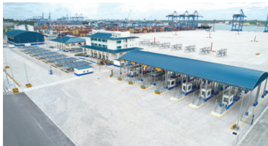
港湾管理事務所(中央)、ゲート(右)、福利厚生棟(左)ならびにワークショップ(左奥)等の港湾施設
