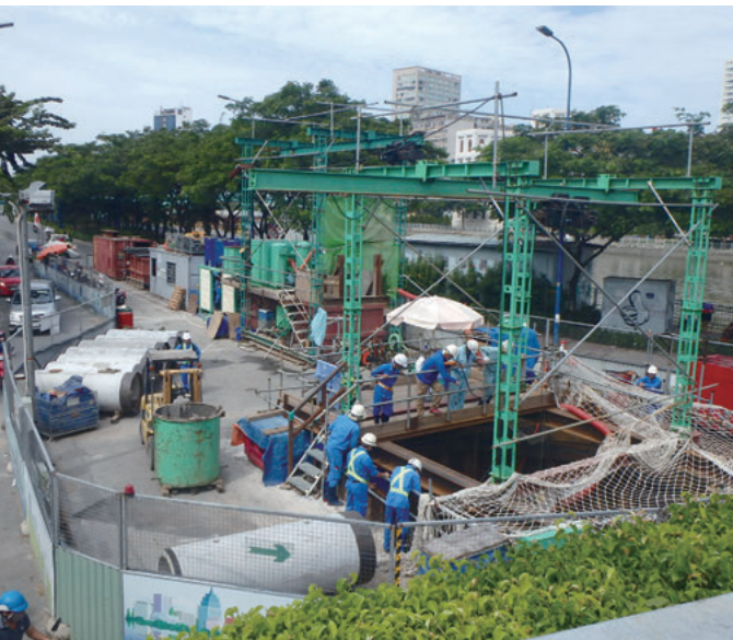
ホーチミン市で初めての推進工法による大規模下水道管渠工事に市内に設けた発進基地
