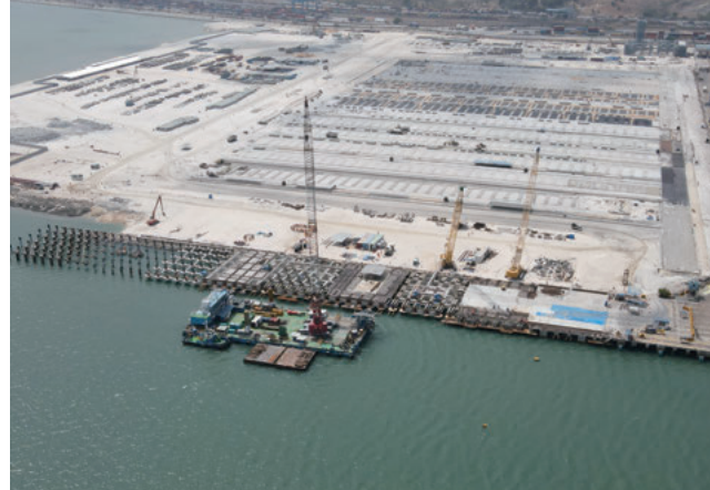
最盛期の現場全景。海上・陸上土木や建築・設備工事を同時施工し、約2000人の作業員が従事
