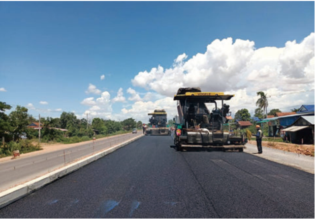
愛亀が海外で初めて携わった大型舗装工事件件（ODA） （カンボジア国 国道5号線改修事業の延長44.1kmの舗装状況）
