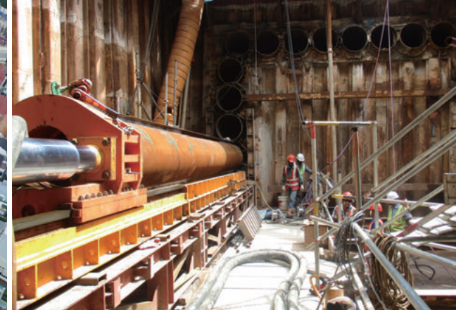
引抜型推進機によるパイプルーフ工
