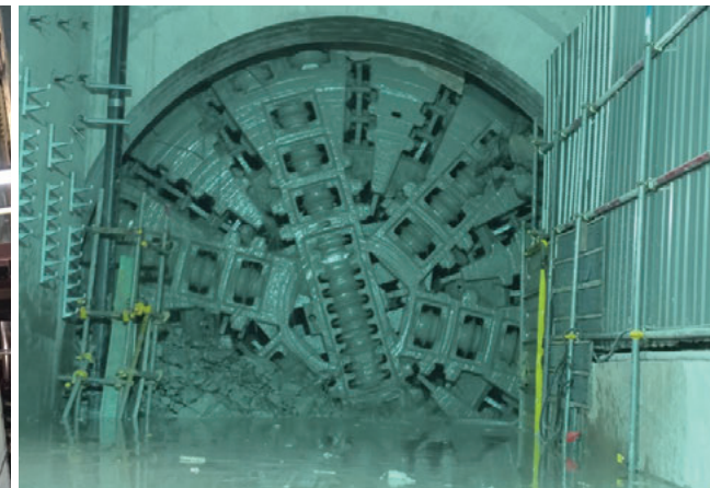
花崗岩と軟弱な沖積層からなる複雑な地質を掘削して到達したシールドマシン
