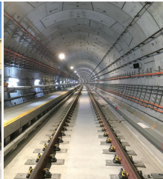
完成したシールドトンネル
