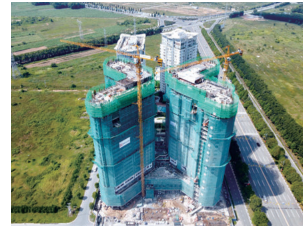
Photo of SORA gardens2 construction phase
