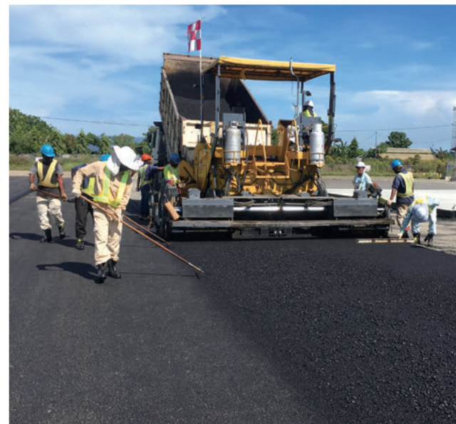
エプロン拡張のためのアスファルト舗装工事の様子
