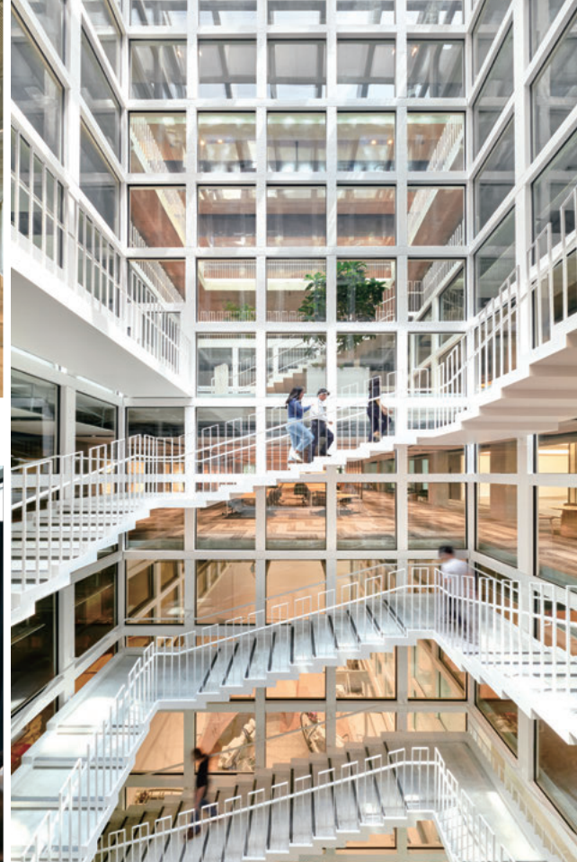
建物全館に自然光を導き上下階の移動と交流を促す K/SHAFT
