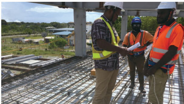
株式会社ジャイロスが雇用していた現地人技術者による品質検査の様子
