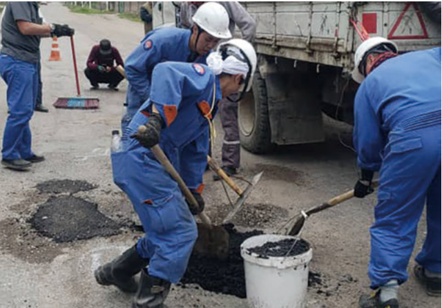
キルギス国 全天候型舗装補修材の施工技術移転状況 （製造技術移転にて製造したキルギス製の舗装補修材を使用）
