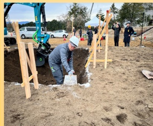
端部はスコップを用いて人力作業
