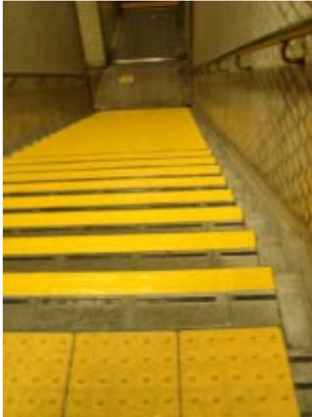
図 2-22 段鼻の全体に黄色テープを貼り付けた事例
