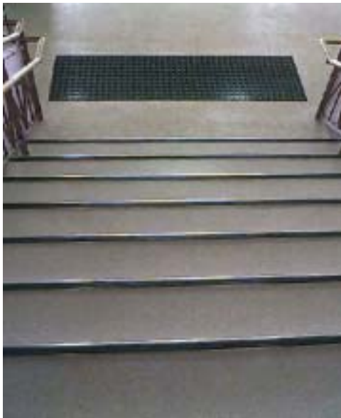
図 2-20 滑り止めと階段のコントラストが高い事例
