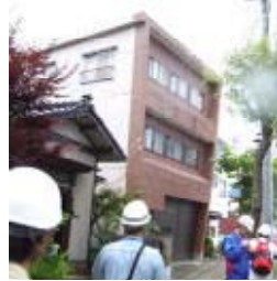
大きく傾いた鉄骨造建築物
