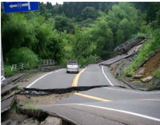
国道8号長岡市大積千本町
