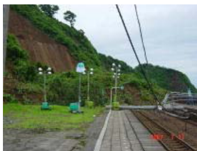
青海川駅付近の土砂流入
