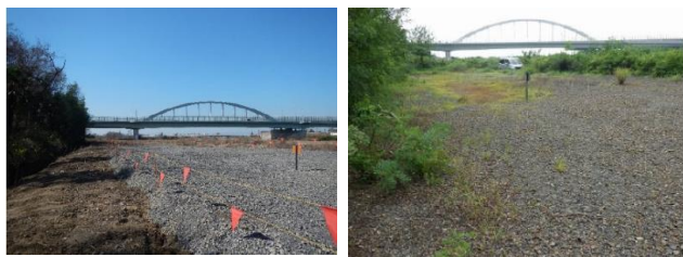
図-7 再繁茂状況（左：初回施工直後 右：2023年8月時点）
