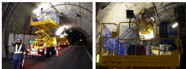
写真-1 従来点検手法によるトンネル点検状況
