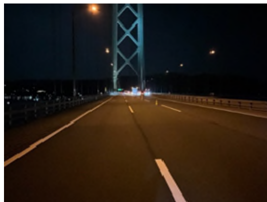
写真-1 現行海峡部照明設備
