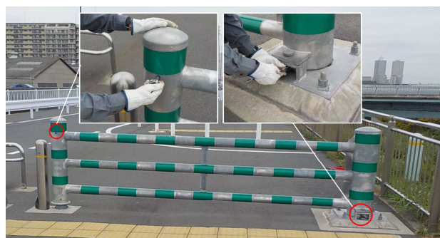
写真2 荒川下流河川事務所管内の車止めゲート
