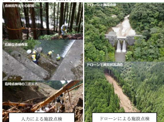
図－2 砂防施設の点検状況
