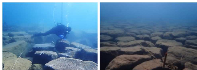
写真-7 本体ブロック据付面の敷き均し状況
