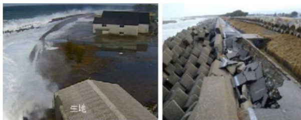
写真-2 過去の被災状況
