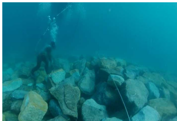
写真-5 岩石投入後の敷き均し状況
