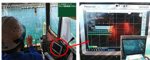
写真-4 「見える化」クレーン操作
