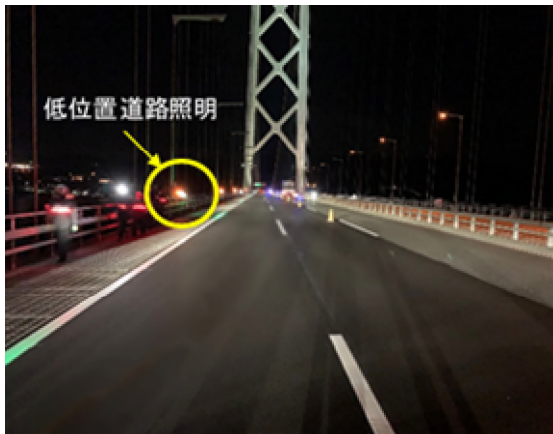
写真-6 明石海峡大橋実橋試験
