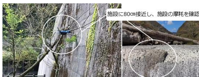
図－9 近接撮影ドローン飛行状況
