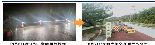
図-4 県道70号線の規制状況
