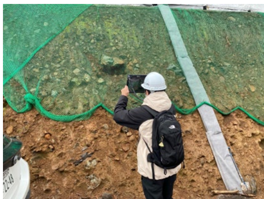
図-4 実際に職員が計測している様子
