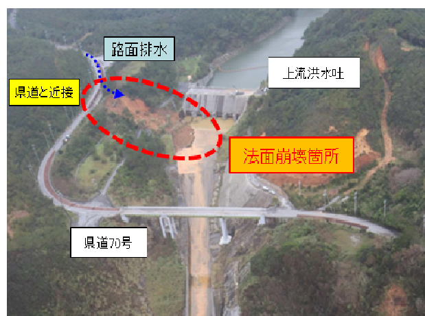
図-2a 上流洪水吐右岸の法面崩壊箇所
