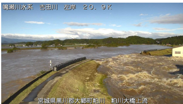
図-1 2019年（令和元年）東日本台風 被災状況
