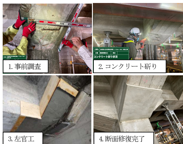
写真4 上部工の断面修復施工手順
