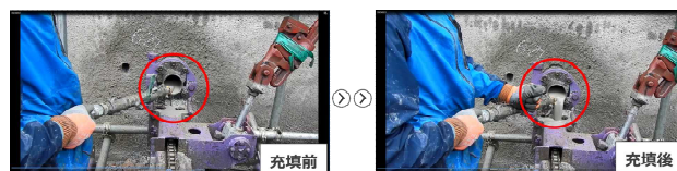
写真-5 鉄筋挿入工のグラウト材充填確認への活用例
