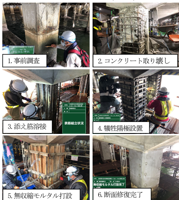
写真-3 脚柱部の断面修復施工手順
