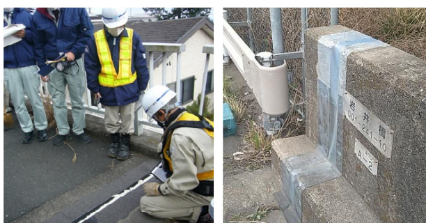
写真-2 D I Yによる橋梁補修の様子
