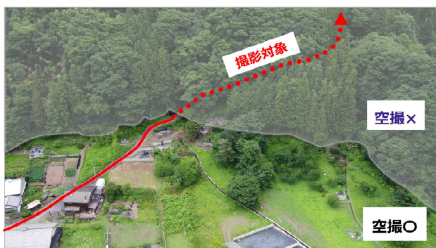
写真-3 計画砂防堰堤への進入路に係る検討資料（空撮写真）
