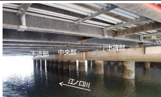
写真-2 桁下現況写真
