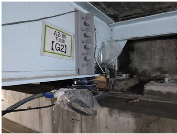
写真-10 支承部のジャッキアップ状況
