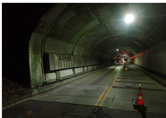
（写真-2 坑口付近の状況（夜間））
