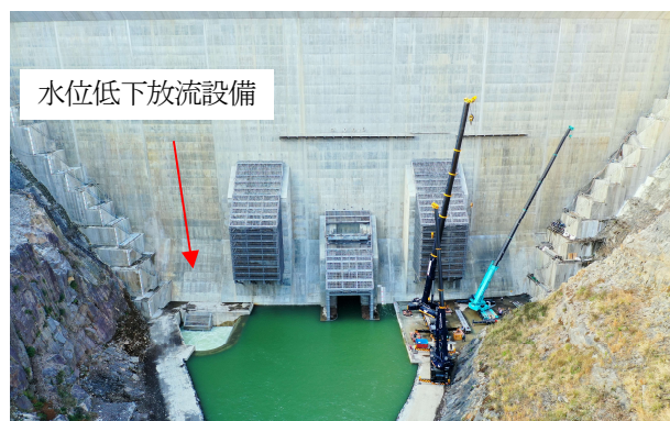
写真－2 水位低下放流設備
