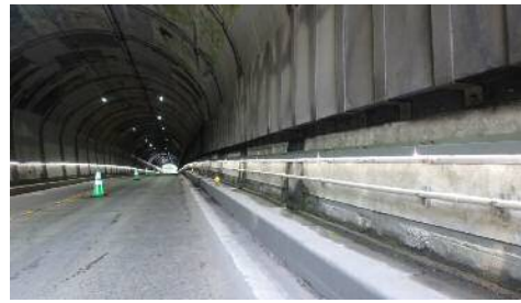
(写真-12 上り線側の設置状況)
