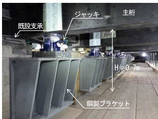
写真-5 鋼製ブラケットによる桁ジャッキアップ
