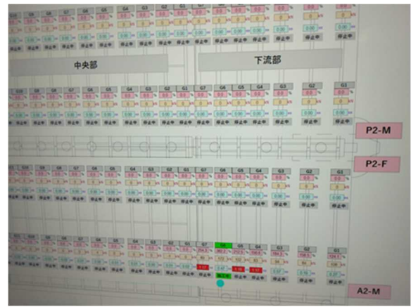
写真-11 ジャッキアップ状況管理画面
