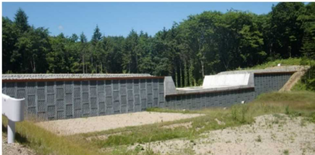
写真2 小泉の沢川1号砂防堰堤
