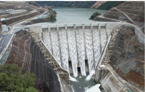
写真－6 ダム越流様子
