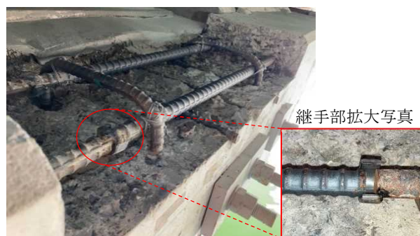
写真-8 新NT工法Ⅱによる切断鉄筋の復旧
