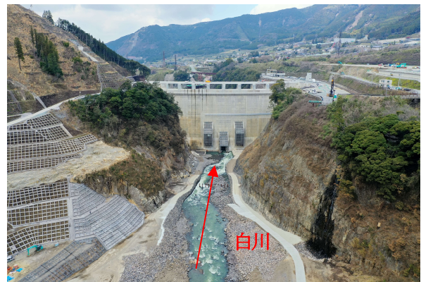
写真－1 ダム上流側から下流側を望む(平常時)
