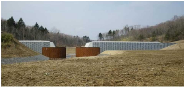
写真1 小泉の沢川遊砂地
