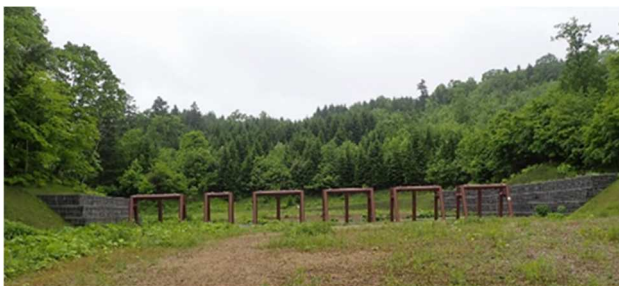
写真3 小泉の沢川左支川流木捕捉工
