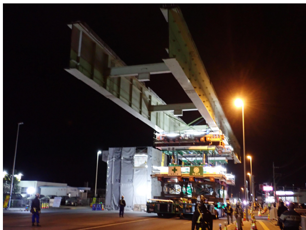
写真-3 多軸台車走行状況
