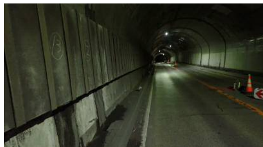
（写真-3 中間部分の状況（夜間））
