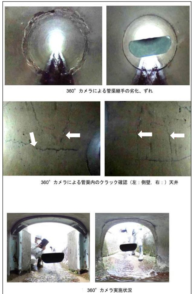
図-8 360°カメラを用いた函渠内調査結果事例
