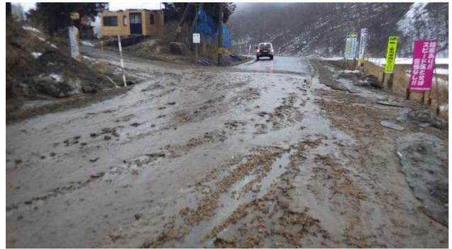
図-10 融雪出水による厚真町高岡地区の土砂流出
