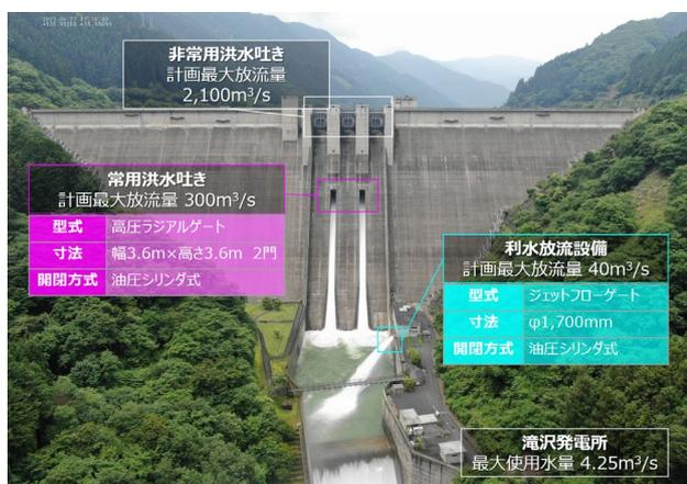
写真-1 滝沢ダム放流設備の構成
