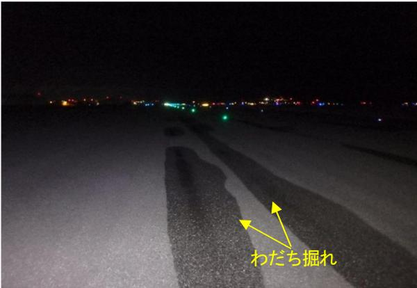
図-2 誘導路の劣化状況 (わだち掘れ)
