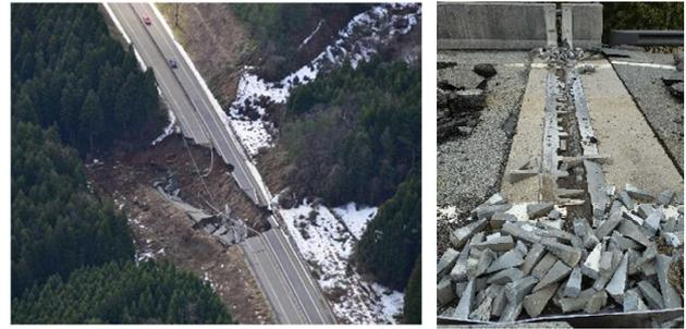
図-5 能越自動車道の大規模な盛土崩落（左）、
