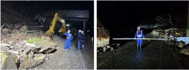
図-4 電線を巻き込んだ落石撤去方針の判断（左）
