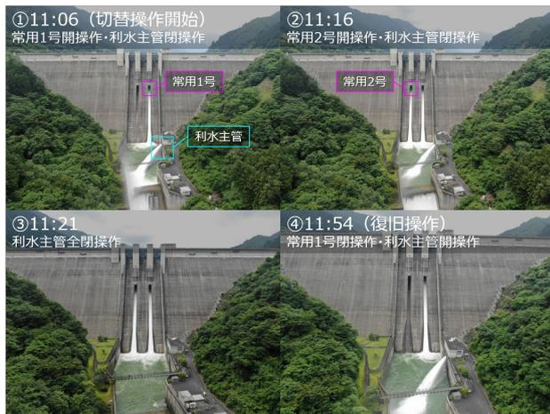
写真-3 遠隔操作試行状況
