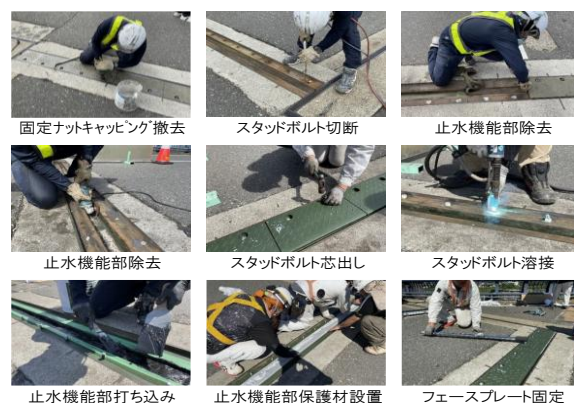
図-17 試作品設置橋梁での補修業務実施状況
