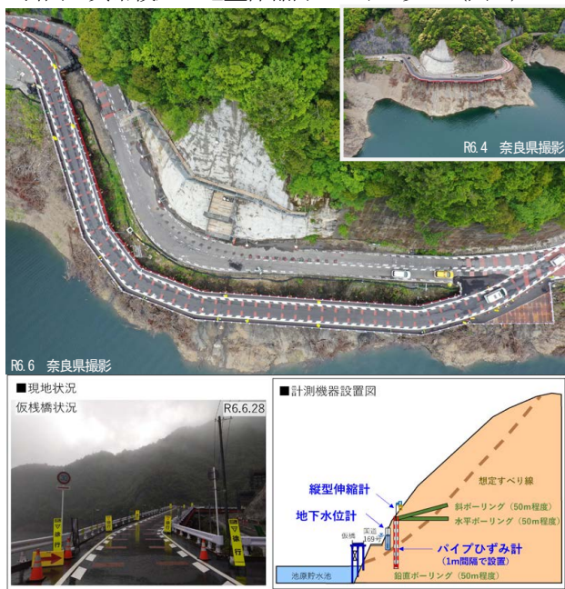
図-3 仮栈橋による片側交互通行の状況と計測器
