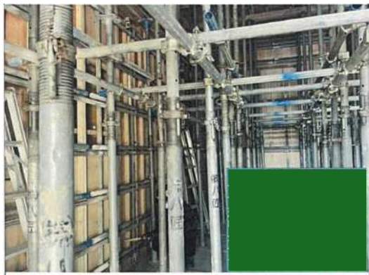
図-10 型枠支保工
