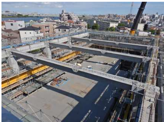
図-11 部材設置状況
