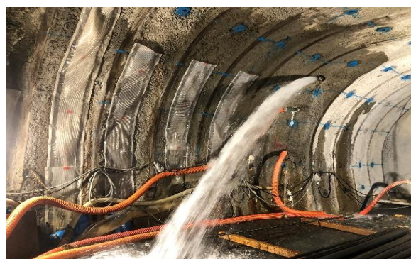
写真-6 TD=2,300m 多量湧水(3t/min)
