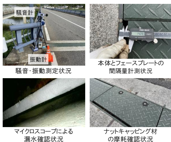
図-15 伸縮装置試作品設置橋梁のモニタリング状況
