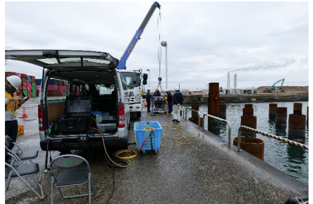
図-5 ROV/ASVの海上への投入状況
