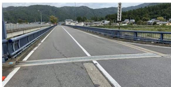
図-7 試作した伸縮装置の設置事例
