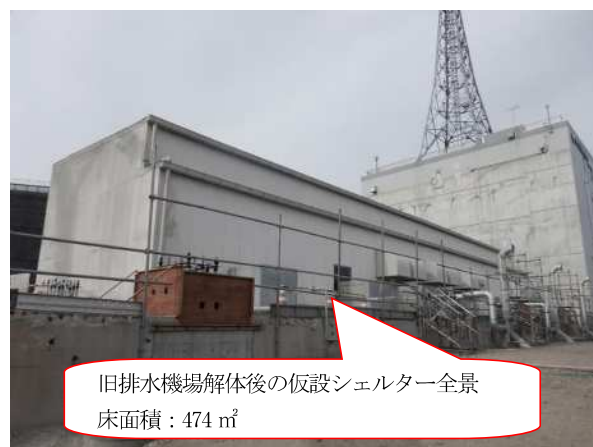
図-8 仮設シェルター
