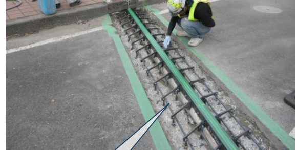
構造的な制約があり、健全な部分も含めた全体更新
