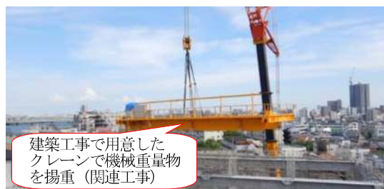
図-14 揚重機の共用
