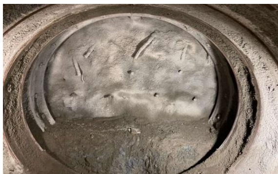
写真-11 円形二重支保施工状況
