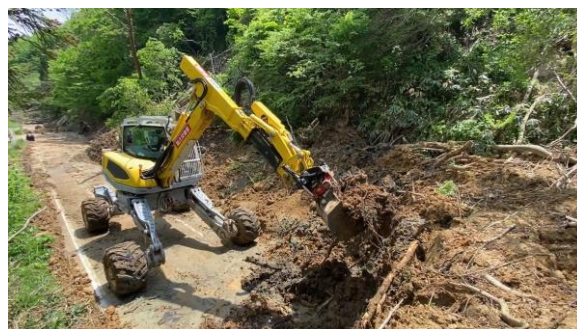
図-11 土砂撤去
