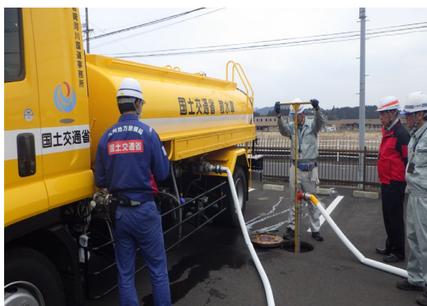
写真-7 簡易水槽への給水
