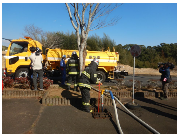
写真一4 散水車への給水
