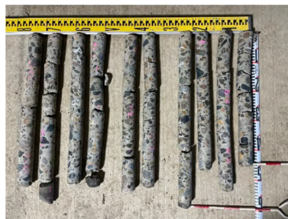
写真-4 採取したコンクリートコア
