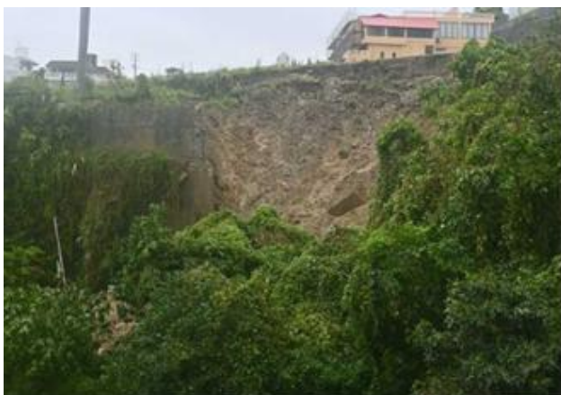
写真-1 沖縄県浦添市沢岬の土砂災害状況
