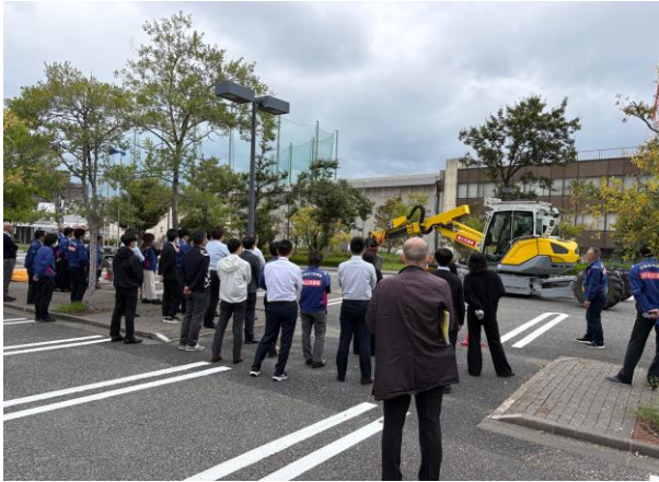
図-6 職員向けのスパイダー見学会 (北陸地方整備局 駐車場にて2025.10実施)
