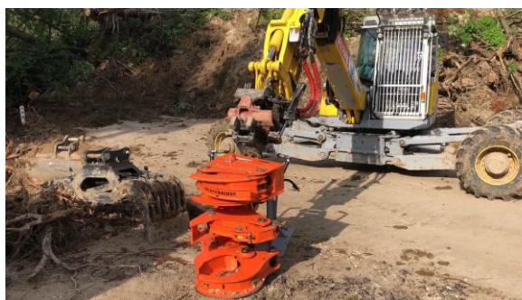
図-13 アタッチメント交換作業
