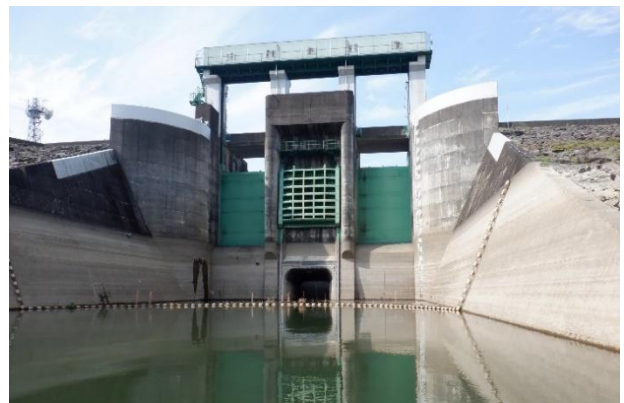
写真-1 寺内ダム洪水吐き部
