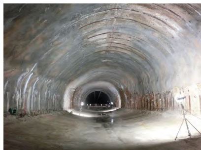
写真-3 一次内空断面補強
